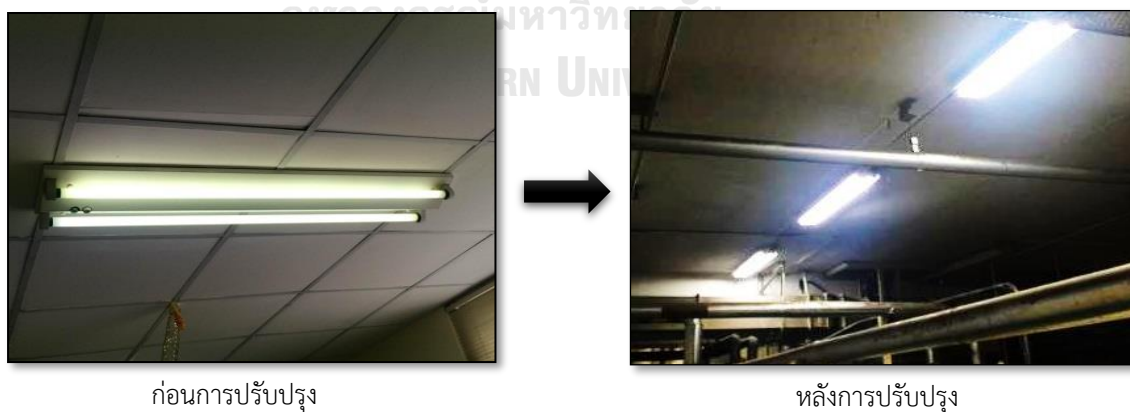
ภาพที่ 4.17 การเปลี่ยนหลอดฟลูออเรสเซนต์ T8 36w เป็นหลอดไฟ LED 18w
