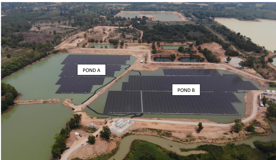
ภาพที่ 4.21 โครงการผลิตไฟฟ้าจากพลังงานแสงอาทิตย์แบบลอยน้ำขนาด 8 mWp ภายในเขตอุตสาหกรรมกบินทร์บุรี อ.กบินทร์บุรี จังหวัดปราจีนบุรี เพื่อจำหน่ายไฟฟ้าให้กับโรงงานผลิตเครื่องใช้ไฟฟ้าภายในบ้านกรณีศึกษา
