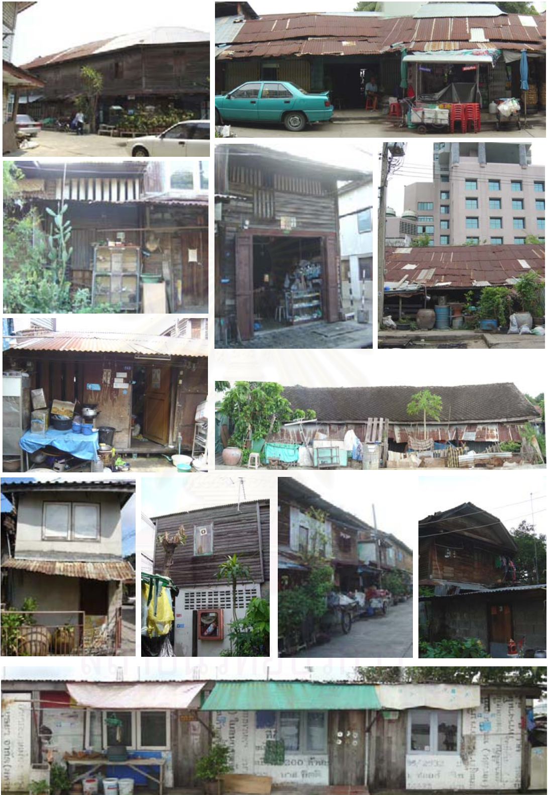
ภาพที่ 4.6 ภาพที่อยู่อาศัยรูปแบบเรือนแถว 1-2 ชั้น ก่อสร้างด้วยวัสดุที่หลากหลาย
