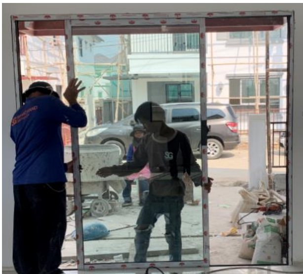
ภาพที่ 93 การใส่น้ำทำความสะอาดกระจกในช่องเปิด
