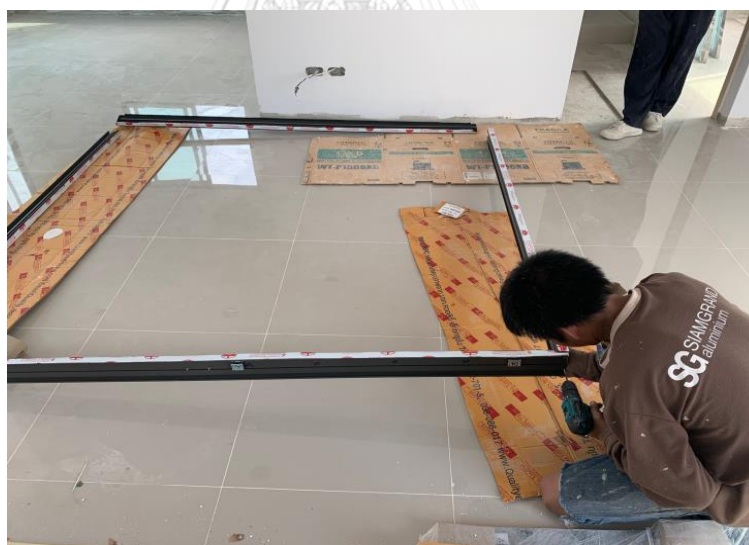
ภาพที่ 90 การประกอบวงกบที่โครงการ
