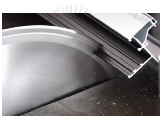
ภาพที่ 75 การบากวงกบอลูมิเนียม
