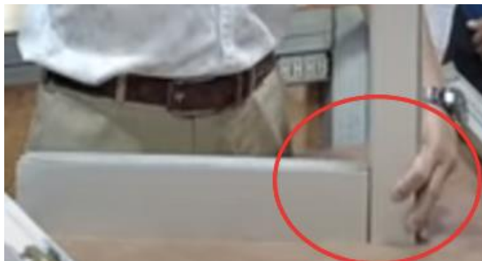
ภาพที่ 27 ลักษณะการประกอบวงกบกลางเข้ากับวงกบข้าง ประกบกัน 90 องศา ที่มา : https://www.youtube.com/watch?v=GfKo86JzanM .
