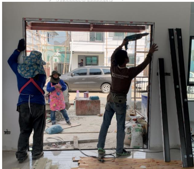
ภาพที่ 92 การยึดวงกบกับผนังช่องเปิด
