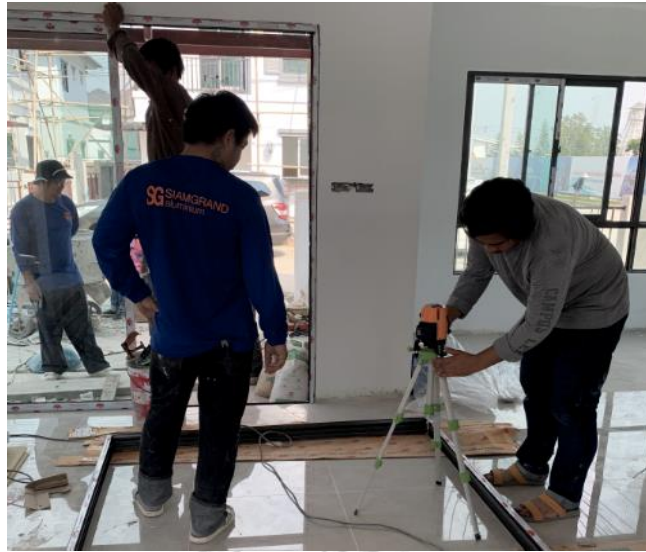
ภาพที่ 91 วัดระดับแนวตั้งในการติดตั้ง
