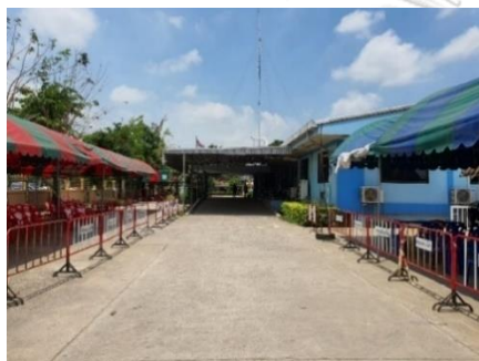
อาคารผู้ป่วยนอกและฉุกเฉิน 1 ชั้น
