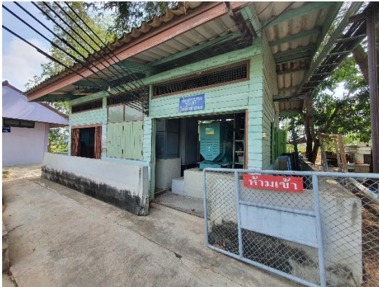
① อาคารงานระบบไฟฟ้า
