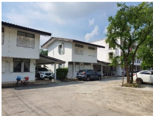
อาคารบ้านพักอาศัย 2 ชั้น
