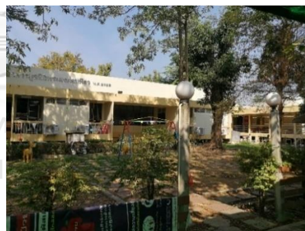
อาคารผู้ป่วยใน 1 ชั้น
