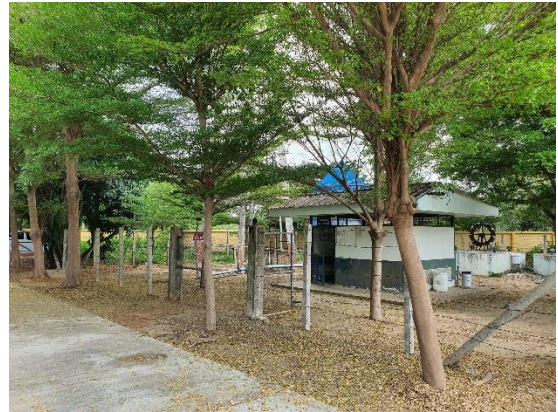
② อาคารงานระบบประปา
