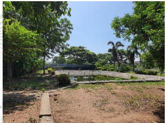
④ งานระบบบำบัดน้ำเสีย
