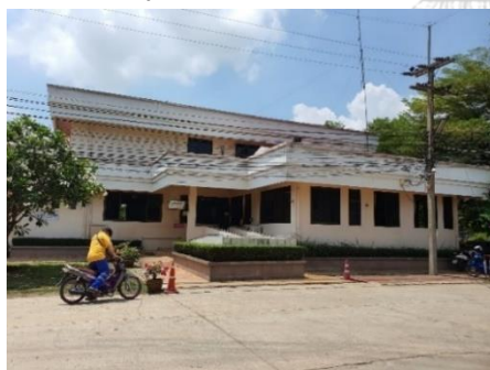
อาคารส่งเสริมสุขภาพและอเนกประสงค์ 2 ชั้น
