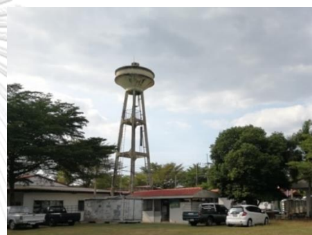
② งานระบบประปา
