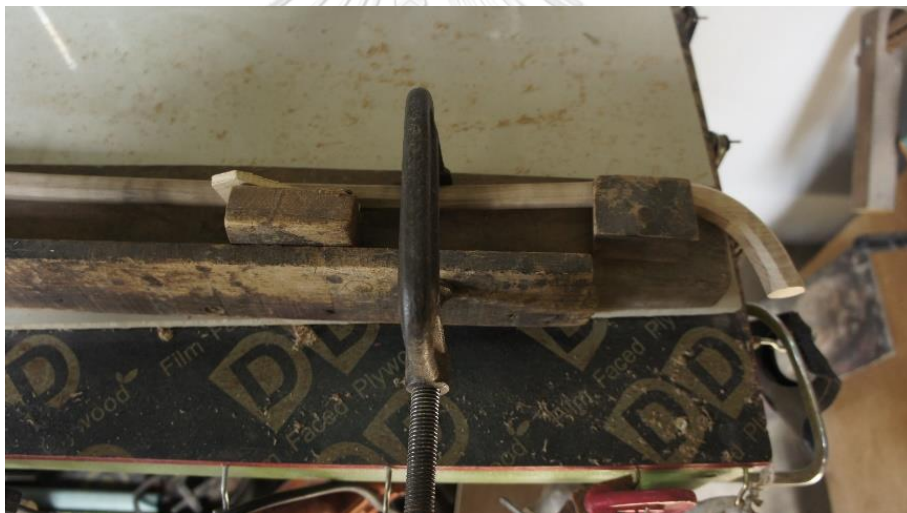
ภาพที่ 130 การใช้เครื่องตัดตัวซีตัดคันทัก
