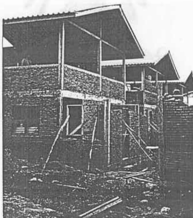
รูปที่ 3.15 แสดงแบบบ้านแฝด 2 ชั้น แบบต่อเติมด้านหน้าและด้านหลัง (แบบ A) สังเกตการต่อเติมด้านหลัง
