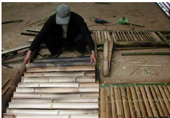
ภาพที่ 6.17 แสดง การติดตั้งบานเกล็ด
