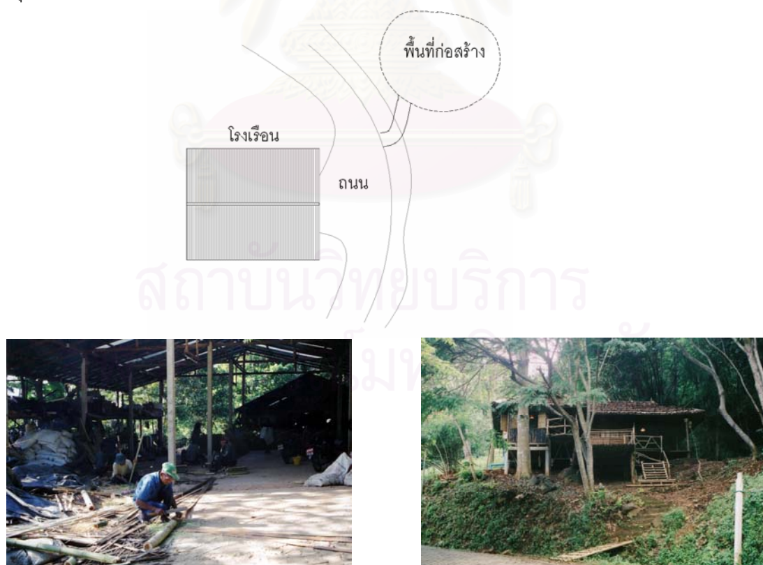
ภาพที่6.3แสดง โรงเรือนที่ใช้สร้างองค์ประกอบอาคาร ภาพที่6.4 แสดง พื้นที่สร้างอาคารตัวอย่าง
