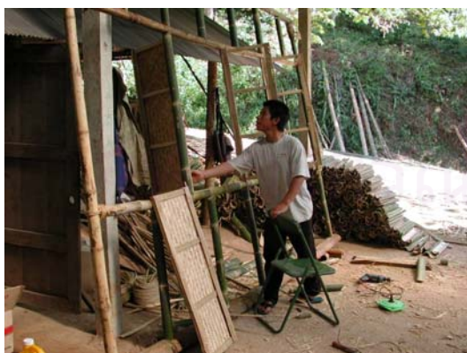
ภาพที่6.11 แสดงทำโครงผนังไม้ไผ่สำเร็จรูป
