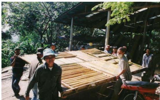
ภาพที่ 6.27 แสดงการเคลื่อนย้ายผนังสำเร็จรูป
