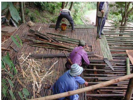
ภาพที่ 6.15 แสดงการติดพื้นไม้ไผ่ซี่ก
