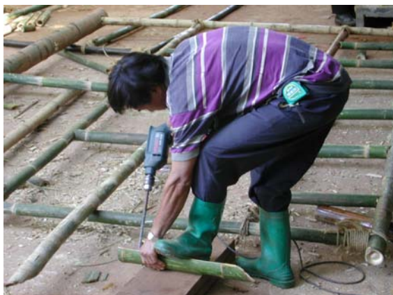
ภาพที่ 6.37 แสดงการเจาะรูร้อยลวดในกระเบื้องไม้ไผ่ชา ภาพที่ 6.38 แสดงการทำกระเบื้องไม้ไผ่ชา
