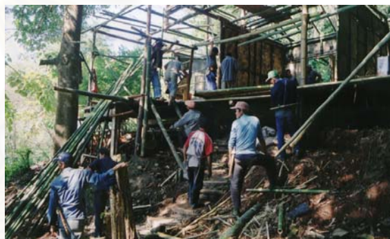
ภาพที่ 6.28 แสดงแรงงานในการติดตั้งผนังกับโครงสร้างหลัก
