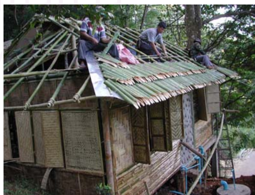
ภาพที่ 6.41 แสดงโครงสร้างหลังคา
