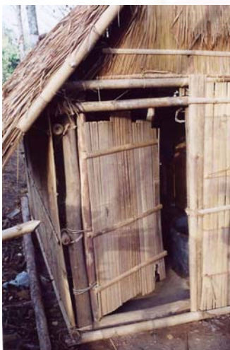
ภาพที่ 4.15 แสดง ประตูห้องน้ำที่สร้างด้วยไม้ไผ่
