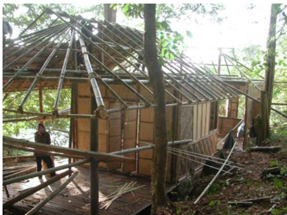
ภาพที่ 6.42 แสดงโครงสร้างหลังคา
