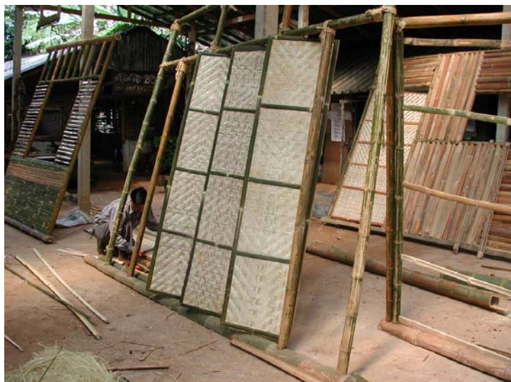
ภาพที่6.8 แสดงการทำโครงผนังไม้ไผ่สำเร็จรูป
