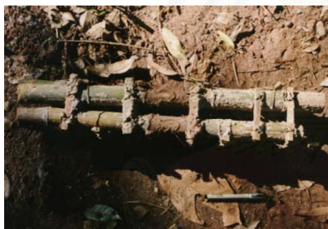
ภาพที่6.5 แสดงโครงเสาไม้ไผ่ที่แกนของเสาคอนกรีต
