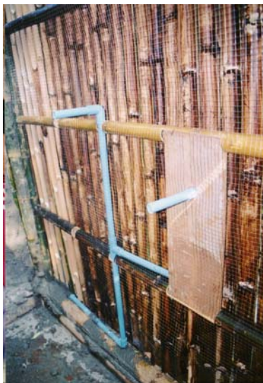
ภาพที่ 6.31 แสดงโครงผนังไม้ไผ่ฉาบดิน
