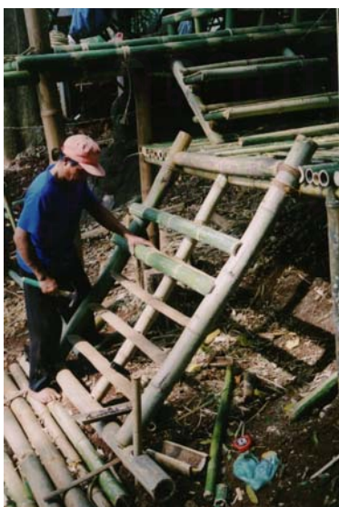
ภาพที่ 6.35 แสดงการติดตั้งบันไดไม้ไผ่แบบที่ 1
