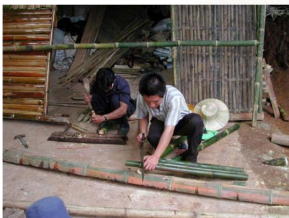
ภาพที่ 6.19 แสดงการทำผนังไม้ไผ่สำเร็จรูป
