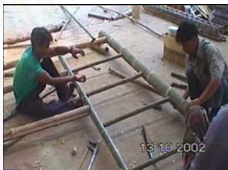
ภาพที่ 6.6การทำโครงผนังไม้ไผ่สำเร็จรูป
