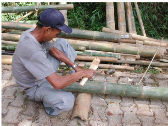
ภาพที่ 6.24 แสดงการทำโครงสร้างพาดช่วงกว้าง 12 ม.
