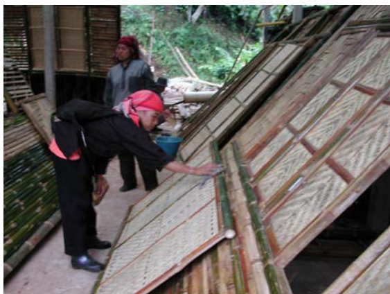
ภาพที่ 6.22 แสดงการทำความสะอาด และทาน้ำมันวานิชผนังไม้ไผ่สำเร็จรูป
