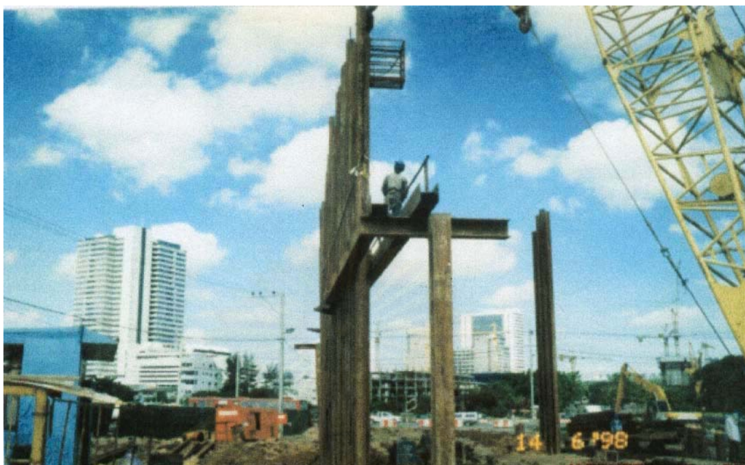
รูปที่ 3.23 แสดงการติดตั้งเสาเข็มพืด
