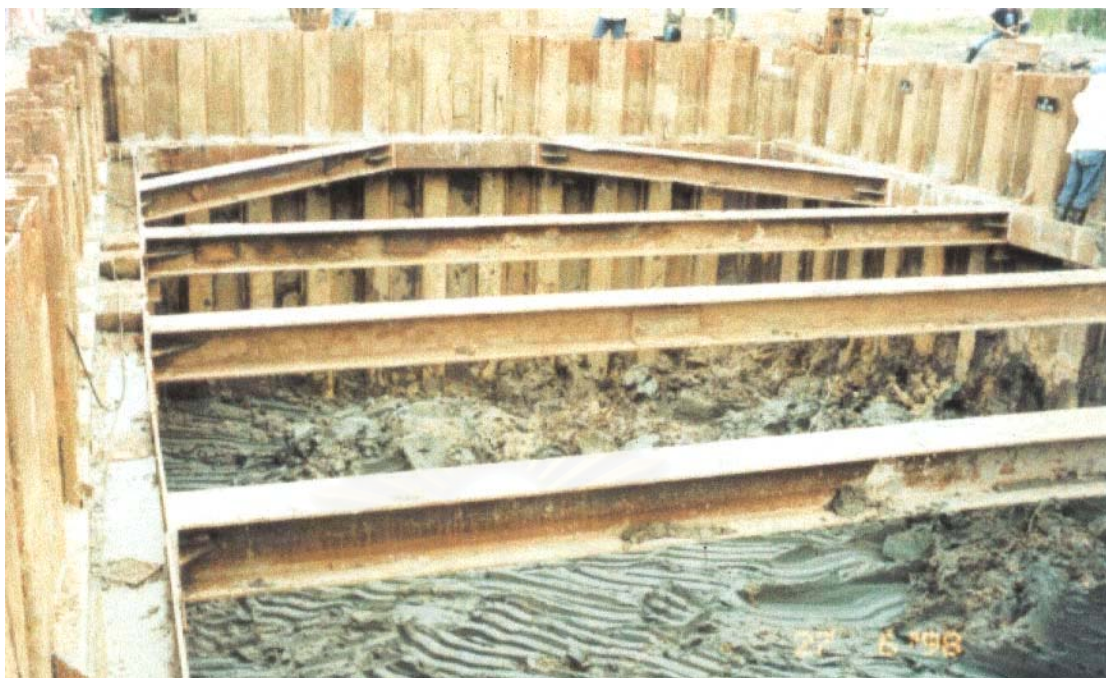
รูปที่ 3.25 แสดงการติดตั้งระบบค้ำยันชั้นที่ 1 ในส่วนด้านปลายของแนวขุด
