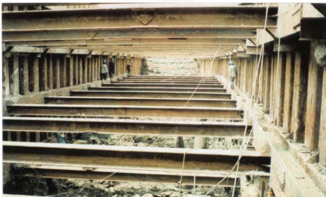
รูปที่ 3.26 (ก) แสดงการติดตั้งระบบค้ำยันชั้นที่ 2
