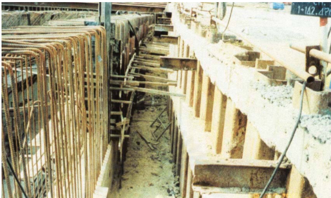
รูปที่ 3.34 แสดงการก่อสร้างผนังอุโมงค์
