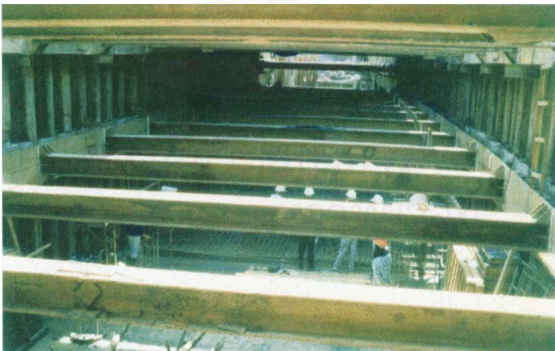
รูปที่ 3.27 แสดงการติดตั้งค้ำยันเมื่อขุดถึงระดับหัวเสาเข็ม
