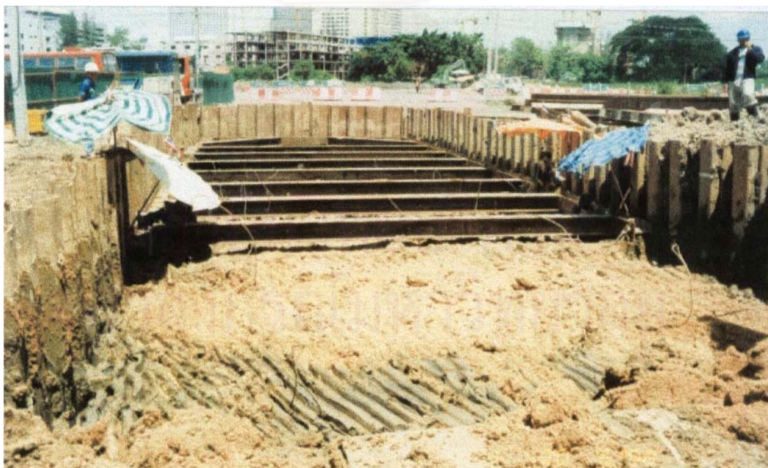
รูปที่ 3.35 แสดงการถมดินกลับสู่ผิวดินเดิม
