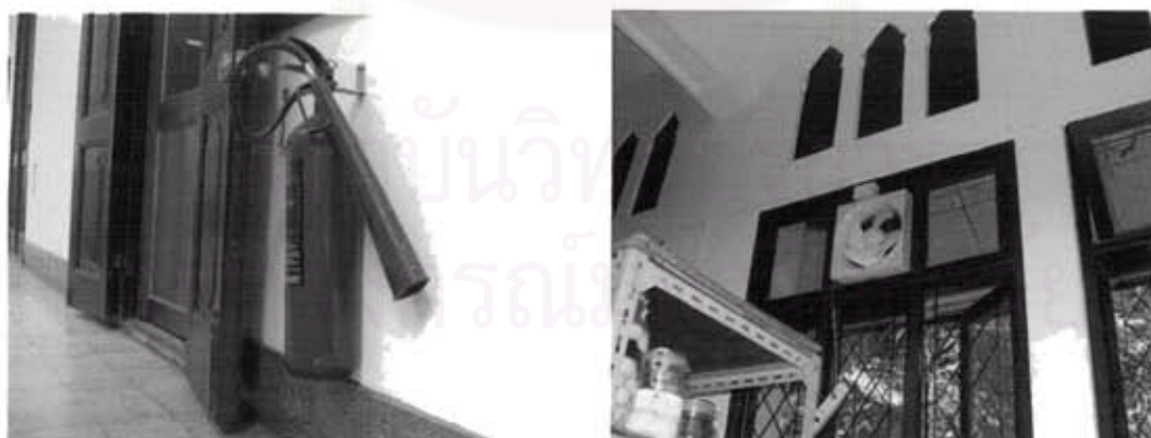
รูปที่ 17 ติดตั้งเครื่องดับเพลิงและระบบระบายอากาศภายในห้องเก็บตัวอย่างสัตว์มีกระดูกสันหลัง
