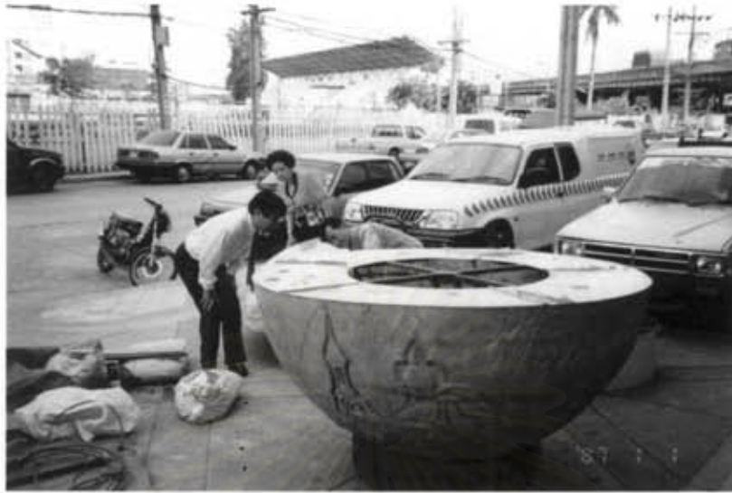
ภาพที่ ๑๐.๕ การประกอบและติดตั้งผลงาน ชั้น B ยังไม่ได้เปิดทอง
