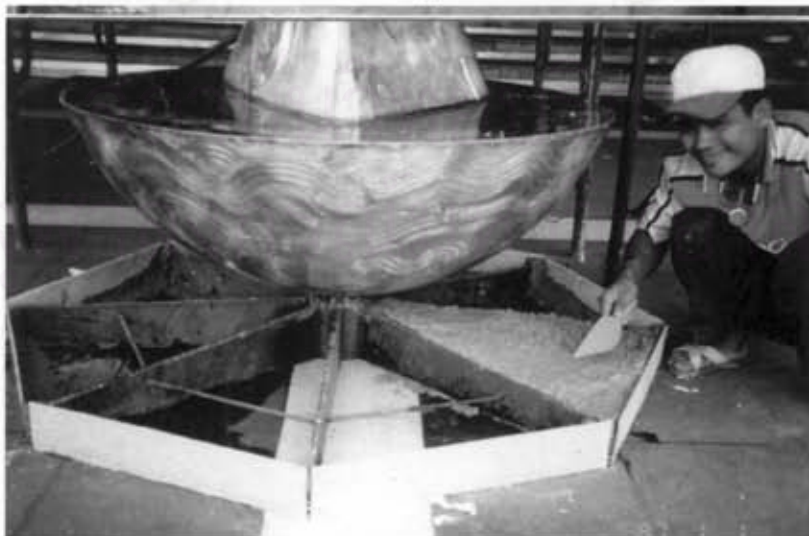
เทคอนกรีตยึด โครงเหล็กฐานแปดเหลี่ยมแปดทิศ
