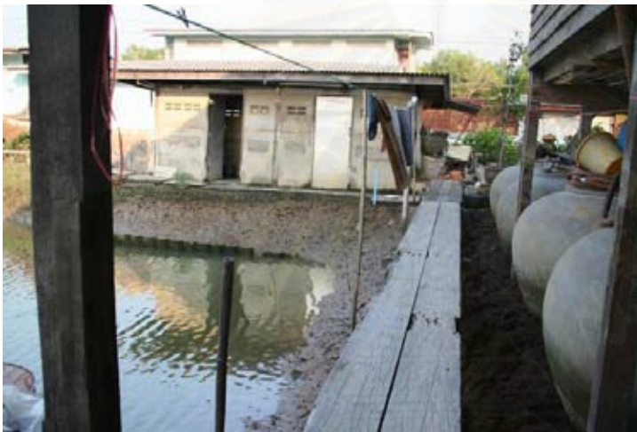
รูปที่ ข-36 แสดงทางเท้าทำจากไม้ กระดานยกสูงเหนือดินเลนขอบตลิ่ง บ่อปูที่อยู่หลังบ้านเชื่อมต่อกับเฉลียงพักผ่อน ด้านนอกมีห้องอาบน้ำและห้องส้วมแยกห่างออกมาประมาณ 5 ม.
