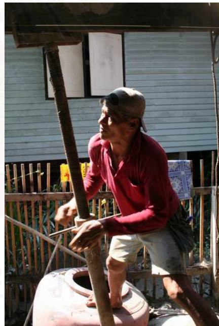
รูปที่ ข-47 แสดงการขันแม่แรงเหล็ก เพื่อค้ำโครงสร้างไม่ให้ยกสูงขึ้น โดยจะขันแม่แรงที่ค้ำโครงสร้างพร้อมกันทุกจุดรองรับ
