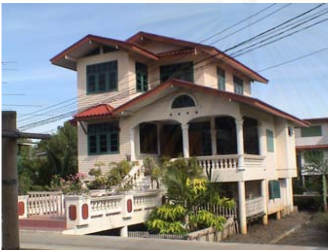
รูปที่ ข-27 แสดงการอาคารพักอาศัย 2 ชั้น สร้างเมื่อพ.ศ.2543 ผลงาน ออกแบบและก่อสร้างของช่างชาญ สิน
