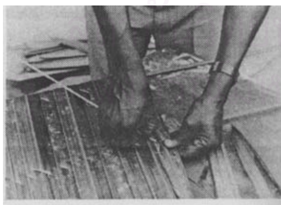
รูปที่ 6-19 และ 6-20 แสดงเทคนิคการก่อสร้างระดับล่าง ทำตับจากสำหรับมุงหลังคา ที่มา : Roland Stulz and Kiran Mukerji ,1984
