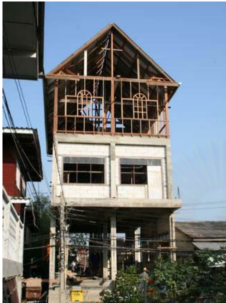
รูปที่ ข-2 แสดงอาคารพักอาศัย 3 ชั้นโครงสร้างคสล.ใช้เสาเข็มเจาะลึก 21ม.
