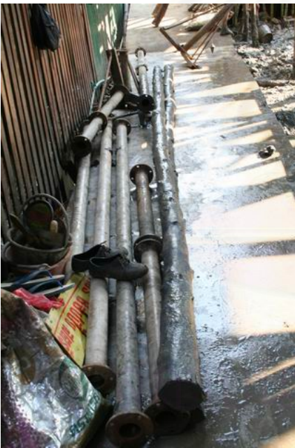
รูปที่ ข-46 แสดงท่อนเหล็กที่ใช้ต่อกันเพื่อค้ำโครงสร้าง มีเส้นผ่านศูนย์กลางประมาณ 7.5 ซม. มีความยาวตั้งแต่ 0.50, 0.80, 1.00, 1.20, และ 1.50 ม.
