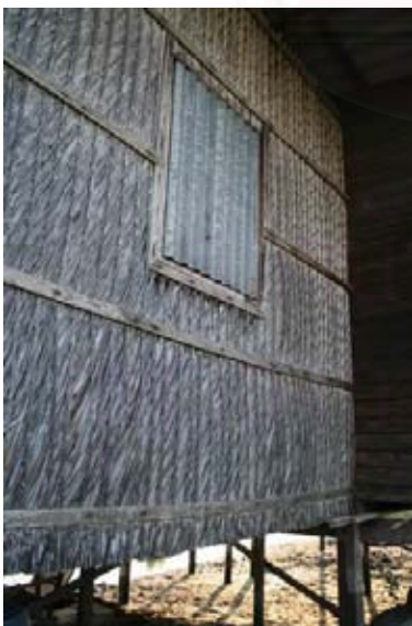
รูปที่ ข-37 แสดงผนังทับจากโครงคร่าวไม้ มีหน้าต่างบานกระทุ้งอยู่กลางผนัง อาคารหลังนี้มีวัสดุที่ใช้ทำผนัง 4 ชนิดคือ 1.ทับจาก 2.ไม้กระดาน 3.แผ่นสังกะสี 4.แผ่นกระเบื้องซีเมนต์ไยหิน
