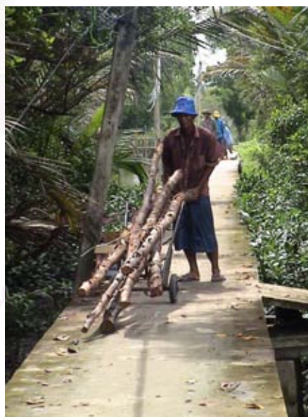
รูปที่ 4-38 การใช้รถเข็นขนเสาเข็มไม้สน ยาว 3 เมตร ที่ถ่ายลงจากเรือแล้วส่งไปตามทางเท้ายังสถานที่ก่อสร้างอาคาร ที่มา: ผู้วิจัย
