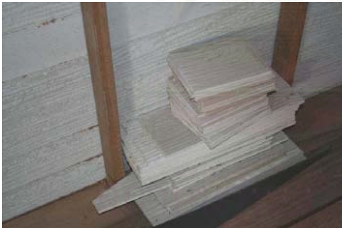
รูปที่ 6-49 แสดงแผ่นไม้ไฟเบอร์ซีเมนต์ ใช้เทคโนโลยีระดับสูงในการผลิต ทำผิวเหมือนไม้ แข็งทนทาน สามารถกันน้ำได้
