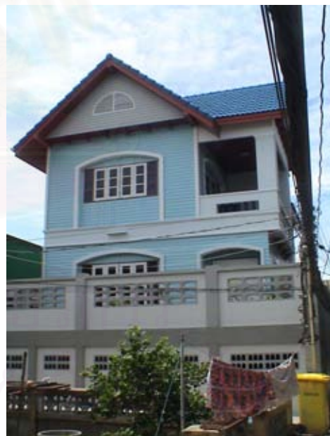
รูปที่ ข-10 แสดงบ้าน 2 ชั้นโครงสร้างคอนกรีตเสริมเหล็ก สร้างเมื่อพ.ศ.2545 โดยมีช่าง เครื่อง ผิวปลั่งเป็นหนึ่งในช่างก่อสร้าง ให้กับบริษัทจักรหงษ์สุวรรณก่อสร้างจำกัด
