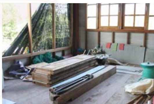
รูปที่ 6-90 แสดงการเก็บวัสดุก่อสร้างที่ใช้เทคโนโลยีระดับกลางในการผลิต โดยเก็บไว้ในอาคารที่กำลังดำเนินการก่อสร้างอยู่
