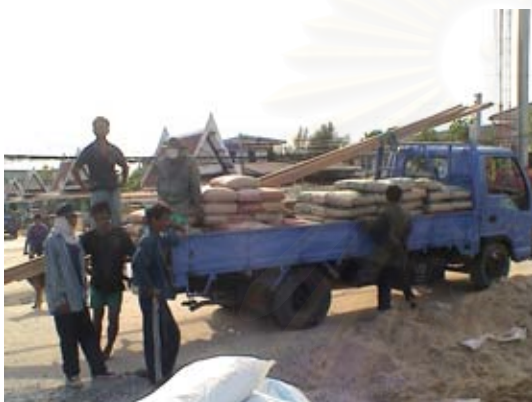
รูปที่ 6-87 แสดง รถบรรทุก 6 ล้อที่ใช้ขนส่งวัสดุก่อสร้างจากร้านค้าวัสดุก่อสร้างที่ห่างจากหมู่บ้านสาขา 8-10 กิโลเมตร ขนมายังลานวัด
