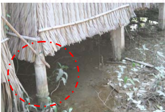
รูปที่ 6-70 แสดงเสาไม้ไผ่ที่ใช้เป็นเสารับน้ำหนักโครงสร้างอาคาร อาคารทั้งหลังใช้วัสดุจากธรรมชาติเป็นหลักจึงทำให้มีน้ำหนักเบา เสาไม้ไผ่จึงรับน้ำหนักอาคารได้
