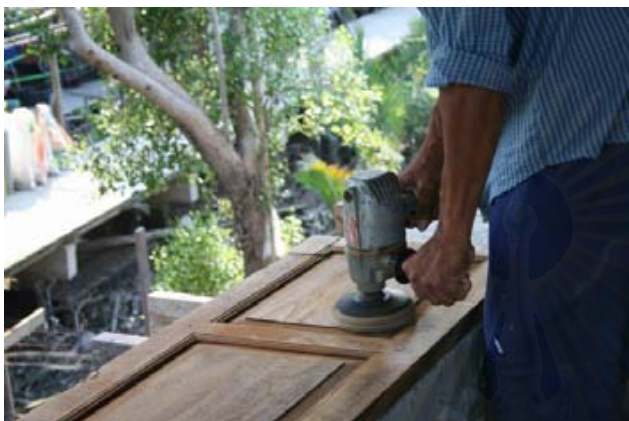
รูปที่ 6-42 แสดงช่างที่ใช้เทคนิคการก่อสร้างระดับกลางในการใช้เครื่องมือขัดผิวหน้าต่างไม้สัก
