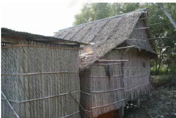
รูปที่ 6-69 แสดงอาคารที่ก่อสร้างด้วยตับจากตากแห้งเป็นวัสดุหลัก ใช้กันผนังและใช้เป็นวัสดุมุงหลังคา
