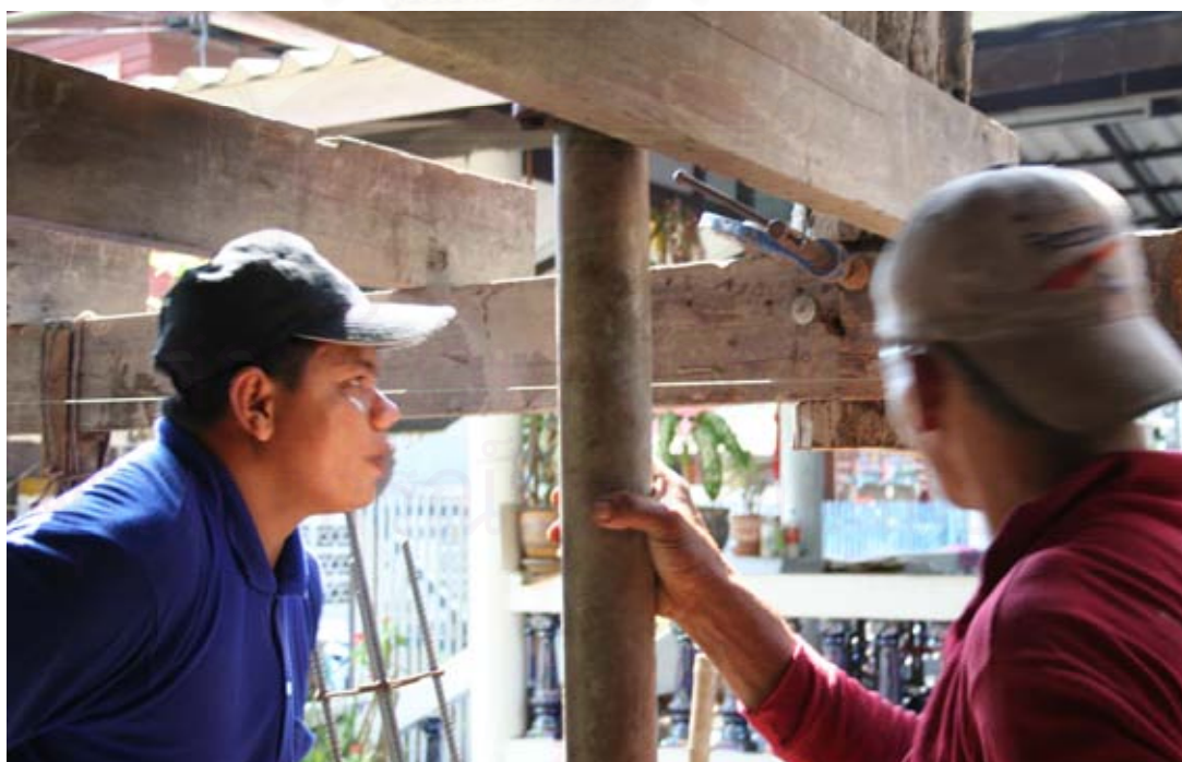
รูปที่ 6-47 แสดงการใช้ประแจเหล็กจับโครงสร้างไม้ให้อยู่ในระดับเดียวกัน ต้องอาศัยการวัดระดับที่แน่นอน และรู้ตำแหน่งในการบีบโครงไม้เข้าด้วยกัน ต้องใช้เทคนิคการก่อสร้างระดับกลาง
