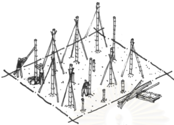
รูปที่ 6-30 แสดงขั้นตอนที่ 5 ปัก เสาไม้ไผ่ลงในหลุมกลบให้แน่น ใช้ค้ำยันยึดหัวเสาไว้
