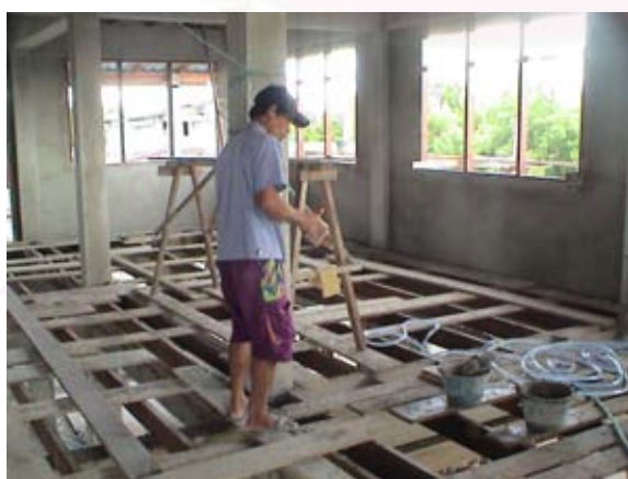
รูปที่ 6-38 แสดงแรงงานที่ใช้เทคนิคการก่อสร้างระดับกลาง ได้ค่าแรงวันละ 300-350 บาท
