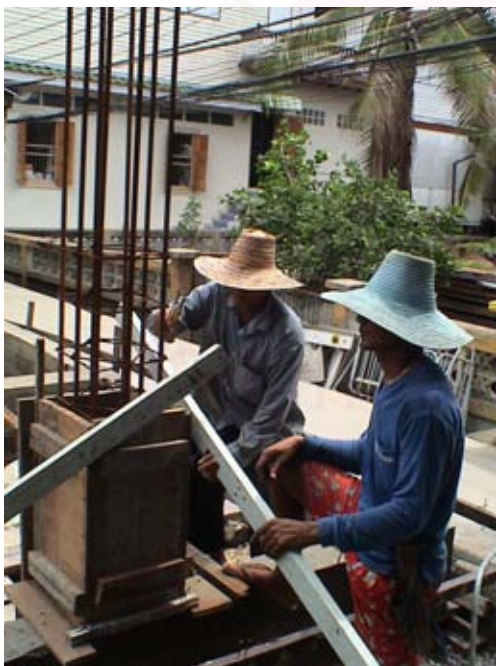
รูปที่ ข-13 แสดงการช่วยตั้งไม้แบบหล่อโครงสร้างคสล. โดยช่างพิทักษ์ เฑิดชิต
