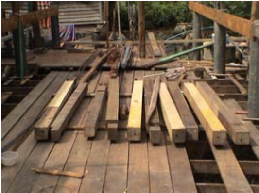
รูปที่ 6-79 แสดงเสาไม้เนื้อแข็งขนาด 8"×8" เป็นไม้ที่ผ่านการถนอมรักษาโดยการอบ เป็นวัสดุที่ผลิตจากเทคโนโลยีการผลิตระดับกลาง โดยมีโรงงานไม้แปรรูปอยู่นอกหมู่บ้านสาขลา
