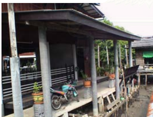
รูปที่ 5 - 32 แสดงใต้ถุนเรือนที่ถูกยกพื้นสูงขึ้นจากเดิม 2.50 ม. ทำให้ความสูงระหว่างทางเท้าและพื้นที่ชั้นที่ 2 สูงถึง 3.00 ม.
