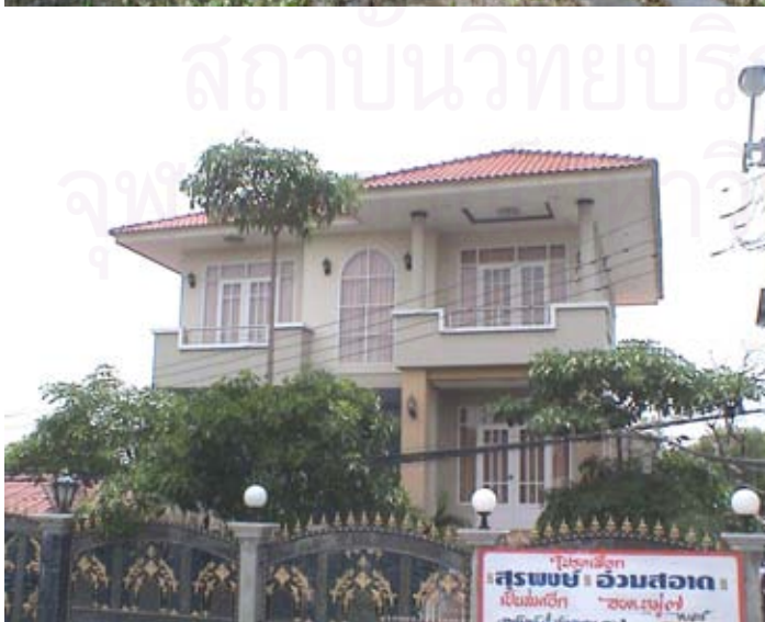
รูปที่ ข-21 แสดงชั้นโครงสร้าง คอนกรีตเสริมเหล็ก สร้างเมื่อพ.ศ. 2540 โดยมีช่าง หลอด เพชร เป็น หนึ่งในแรงงานก่อสร้าง
