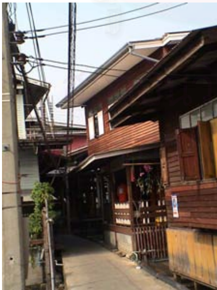
รูปที่ 5 - 52 แสดง อาคารตัวอย่างหลังที่ 2 ที่สร้างระหว่างปี พ.ศ.2526-2537และทำการติดอาคาร ด้วยวิธีต่อเสาและรื้อหลังคา
