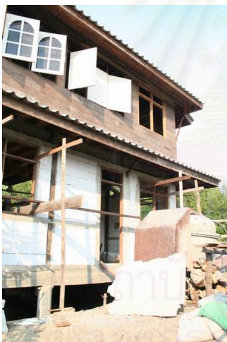
รูปที่ ข-41 แสดง อาคารพักอาศัย 2 ชั้น โครงสร้างชั้นล่างเป็นโครงสร้าง ต่อม่อคาน พื้นคสล. ผนังก่ออิฐมวลเบา, ชั้น2เป็น โครงสร้างไม้ ผนังไม้ยาง ไข้วงกบและ หน้าต่างจากบ้านหลังเก่า ก่อสร้างโดย ผู้รับเหมาเสน่ห์ ผลอินทร์ ให้กับเจ้าของที่เป็นญาติ
