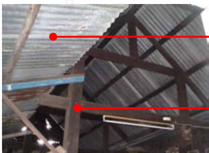
โครงสร้างหลังคา
