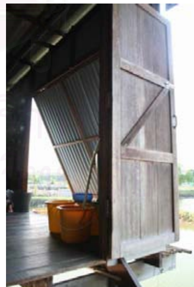
รูปที่ ข-38 แสดงทางเข้าด้านหลังของอาคารเป็นบานประตูไม้ มีผนังตะกั่วที่สามารรถกระทุ้งทั้งฝาเปิดออกสู่ภายนอก
