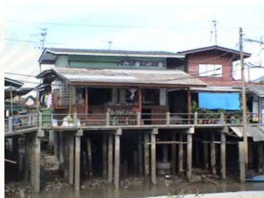
รูปที่ 5-4 อาคารที่ปลูกสร้างเพื่อพักอาศัยและต่อเติมเป็นร้านค้าขายของชำ
