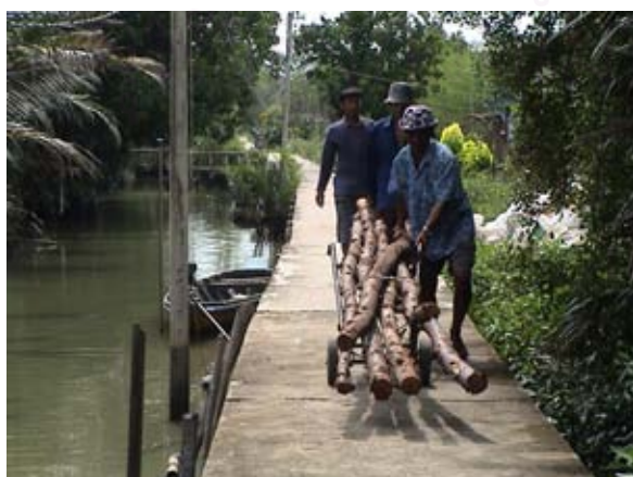
รูปที่ 6-74 แสดง การใช้รถเข็น 2 ล้อบรรทุกไม้สนยาว 3 ม.จำนวน 6 ต้นไปยังสถานที่ก่อสร้าง
