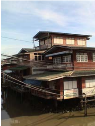
รูปที่ 5 - 44 แสดงอาคารที่สร้างระหว่างปี พ.ศ.2526-2537 และได้รับการดีดอาคารแล้ว
