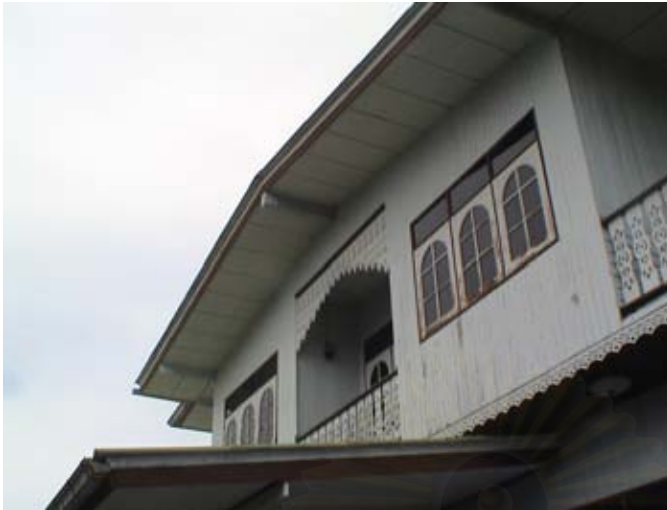
รูปที่ ข-17 แสดงบ้านพักอาศัย 2 ชั้น ผลงานของช่าง ณรงค์ รอดเปีย สร้างเมื่อพ.ศ.2540 ใช้โครงสร้างคสล. ผนังก่ออิฐฉาบปูนและใช้เสาเข็มเจาะลึก21ม.
