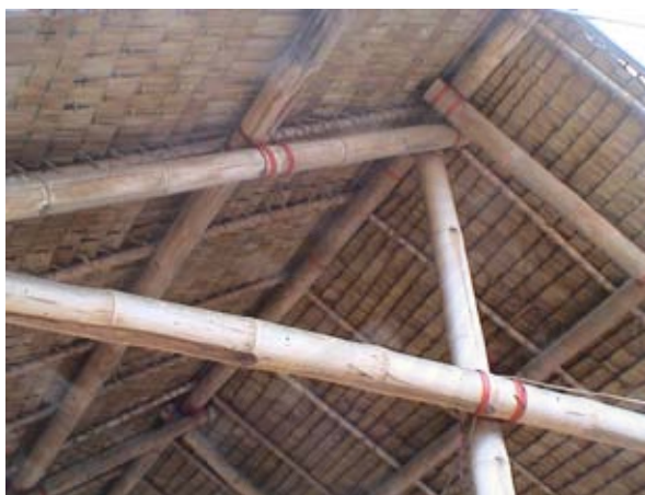
รูปที่ 6-17 แสดงโครงสร้างหลังคาไม้ไผ่ที่ใช้เทคนิคการก่อสร้างระดับล่างกับไม้ไผ่ที่ได้จากการผลิตวัสดุระดับล่าง
