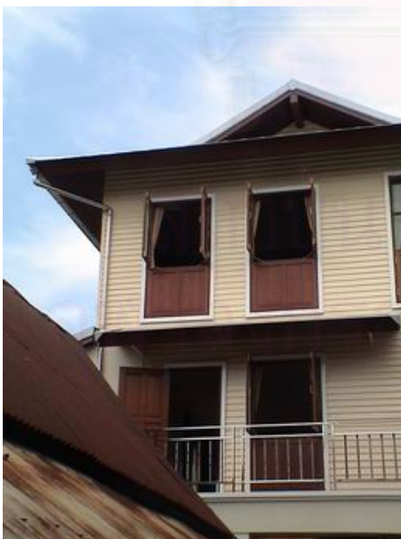
รูปที่ ข-28 แสดงการอาคารพักอาศัย 2 ชั้น สร้างเมื่อพ.ศ.2547 ผลงานออกแบบและ ก่อสร้างของช่างชาญสิน
