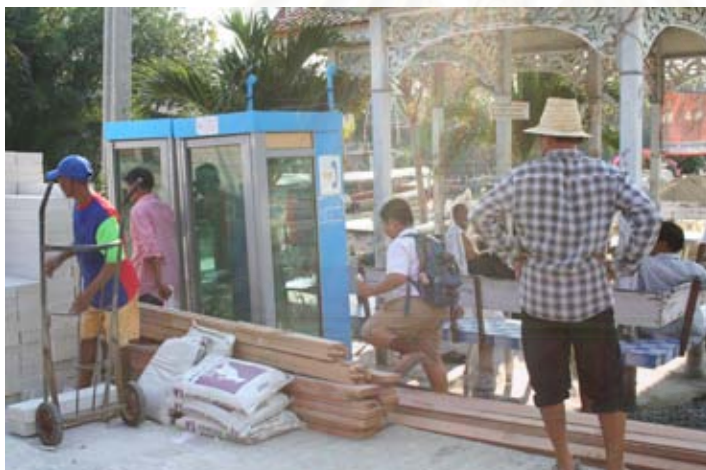
รูปที่ ข-11 แสดงการใช้แรงงานของช่างชาติ ทองเปรม ขนวัสดุ ก่อสร้างจากถนนหน้าวัดสาขลาไปยังสถานที่ก่อสร้าง
