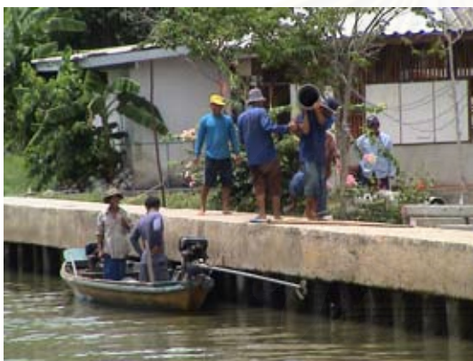
รูปที่ 4-32 การขนวัสดุก่อสร้างจากลานวัดสาขลา ลงในเรือยนต์ก่อนส่งต่อไปยังสถานที่ก่อสร้างในหมู่บ้านสาขลา ที่มา:ผู้วิจัย
