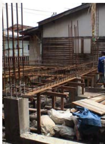
รูปที่ 6-65 แสดงการก่อสร้างอาคารที่ใช้เทคนิคการก่อสร้างระดับสูง โดยการใช้เสาเข็มเจาะลึก 21 ม. และใช้โครงสร้างคสล.เป็นโครงสร้างหลักของอาคาร
