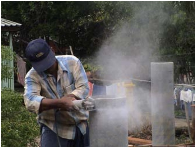
รูปที่ ข-26 แสดงการใช้เลื่อยไฟฟ้าตัด ท่อคอนกรีตที่ใช้ทำเป็นเสาอาคาร โดยช่างชาญสิน แสงงาม
