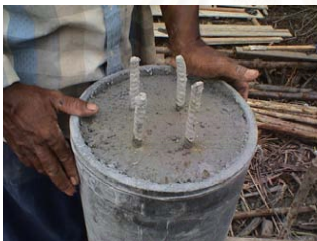
รูปที่ 6-43 แสดงการหล่อเสาคอนกรีตเสริมเหล็ก ที่ใช้ท่อซีเมนต์โยนเป็นไม้แบบ เป็นการใช้นิเทศการก่อสร้างระดับกลาง
