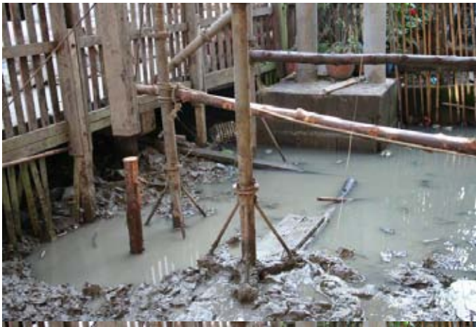
รูปที่ ข-48 แสดงฐานของเสาเหล็กที่ใช้ค้ำโครงสร้าง เป็นฐานเหล็กสามเหลี่ยม เวลาใช้ค้ำจะวางบนท่อนไม้สนก่อนวางบนดินที่ชุ่มด้วยน้ำ ฐานเหล็กนี้มีอายุการใช้งาน 3-4 เดือนจะผุกร่อนจากการเกิดสนิม
