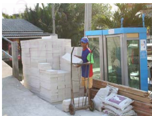
รูปที่ 6-102 แสดงคอนกรีตมวลเบาที่กองเก็บไว้ใกล้กับลานวัดสาขาเพื่อเตรียมขนส่งด้วยรถเข็นสองล้อไปตามทางเท้า คสล.ที่มุ่งไปยังสถานที่ก่อสร้างอาคาร
