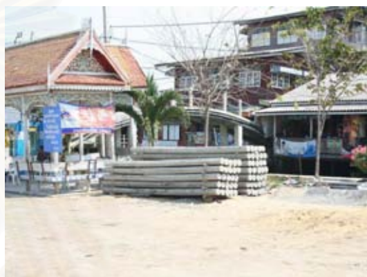
รูปที่ 6-88 แสดงลานวัดที่อยู่ใกล้กับคลอง ใช้เป็นที่เก็บวัสดุก่อสร้างก่อนส่งลงเรือเพื่อขนไปยังบ้านที่ก่อสร้างที่อยู่ใกล้กับคลองในหมู่บ้านสาขา
