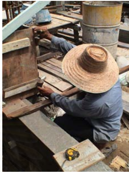
รูปที่ ข-8 แสดงการจับระยะดึงของช่างเครื่อง โดยใช้ลูกดิ่งเหล็ก
