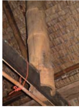
โครงหลังคาไม้ มุงด้วยตับจาก
