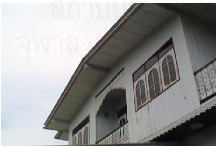
รูปที่ ข-23 แสดงอาคารพักอาศัย 2 ชั้น โดยมีช่างณรงค์ พุฒิดี ร่วมก่อสร้าง
