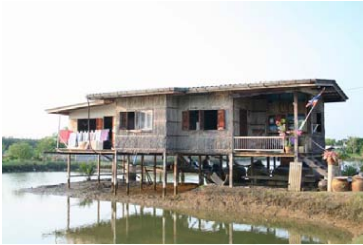
รูปที่ ข-35 แสดงอาคารพักอาศัยชั้นเดียวยกใต้ถุนสูง สร้างเมื่อพ.ศ.2527 โดยช่างประจวบ อาคารหลังนี้ผ่านการดีดอาคารมาแล้ว1ครั้งราวปีพ.ศ. 2544
