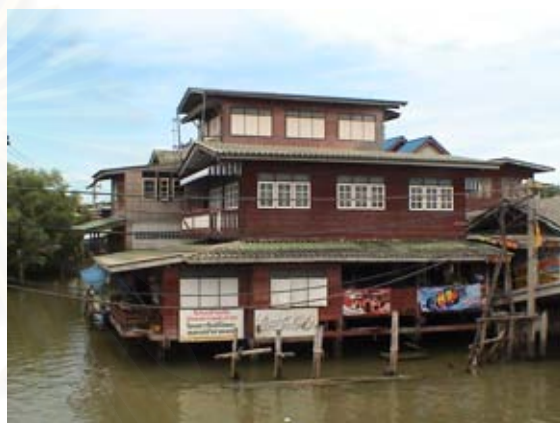
รูปที่ 4-13 ระดับน้ำในคลองบ้านสาขลาที่สูงเพิ่มขึ้นเนื่องจากน้ำทะเลหนุนเข้ามาในคลอง ที่มา:ผู้วิจัย
