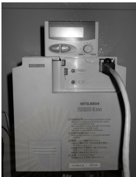
รูปที่ 2-3 ตัวปรับความเร็วรอบมอเตอร์เครื่องสูบน้ำ
