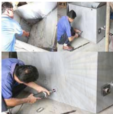
รูปที่ 3.10 แสดงการตรวจสอบความเรียบร้อยของเตาสันดาป พร้อมทั้งตรวจสอบระบบ อากาศไหลเวียน
