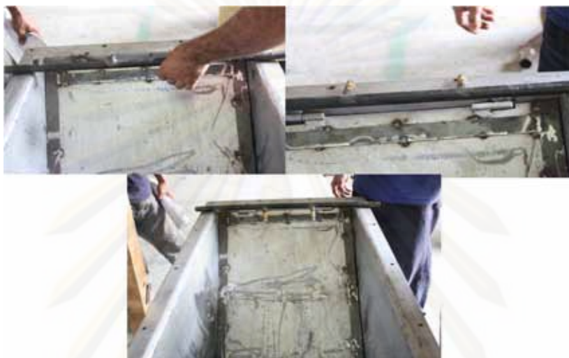
รูปที่ 3.14 แสดงการติดตั้งท่อทางเดินในการส่งน้ำเกลือและปรับปริมาณในการปล่อยน้ำเกลือ
