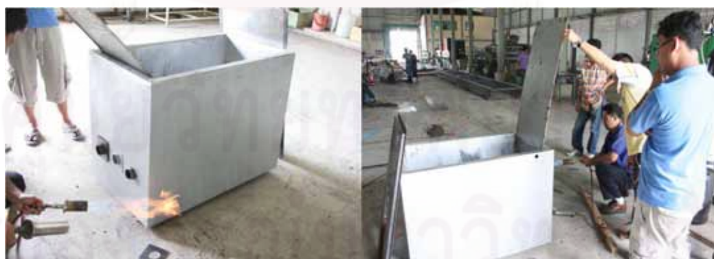
รูปที่ 3.13 แสดงการประกอบทุกส่วนเข้าด้วยกันและประกอบแผงพาความร้อนด้านบนสุดของเตาเผา
