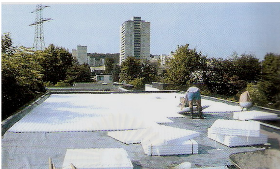
ภาพที่ 2.7 แสดงตัวอย่างการปูแผ่นระบายน้ำสังเคราะห์บนวัสดุป้องกันรากของพืช
