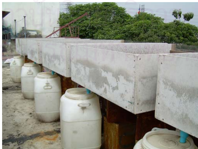
ภาพที่ 3.16 แสดงการติดตั้งถังรองรับน้ำกับกระบะทดลอง
