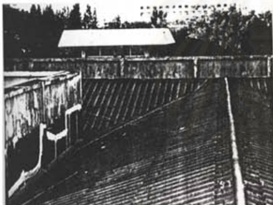
(3) สภาพหลังคากระเบื้องลอนคู่ อาคารจามจุรี 1
