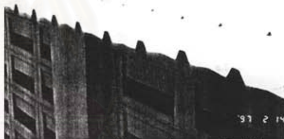
(4) การระบายอากาศใต้หลังคา ช่วยลดอุณหภูมิเหนือฝ้า
