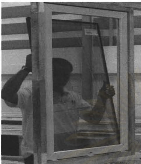
ขั้นตอนที่ 5 ใส่กระจกเข้ากับกรอบบาน
