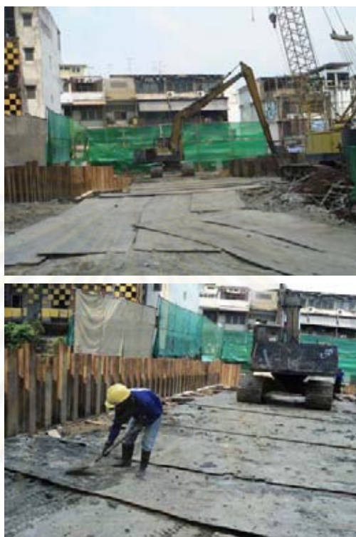
รูปที่ 4.38 แสดงการนำแผ่นเหล็กมาวางในพื้นที่ก่อสร้างของโครงการก่อสร้างที่ 2
