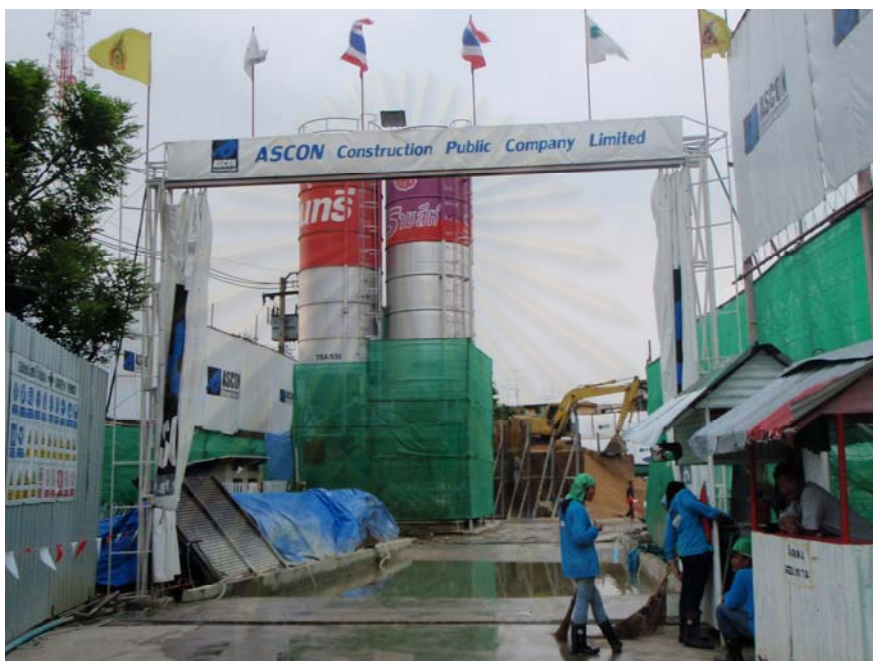
รูปที่ 4.21 แสดงประตูบริเวณทางเข้า-ออกของโครงการก่อสร้างที่ 1
