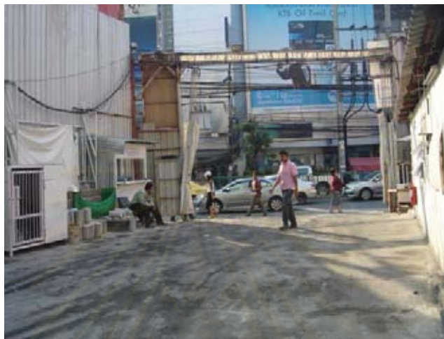
รูปที่ 4.23 แสดงประตูบริเวณทางเข้า-ออกของโครงการก่อสร้างที่ 3
