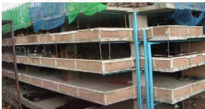
รูปที่ 4.19 แสดงงานก่ออิฐผนังของโครงการก่อสร้างที่ 1
