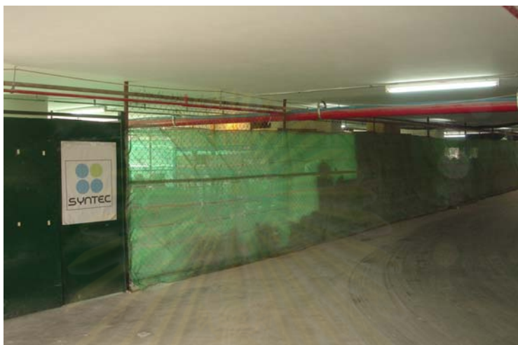
รูปที่ 4.15 แสดงการจัดทำสถานที่จัดเก็บวัสดุก่อสร้างที่ของโครงการก่อสร้างที่ 3
