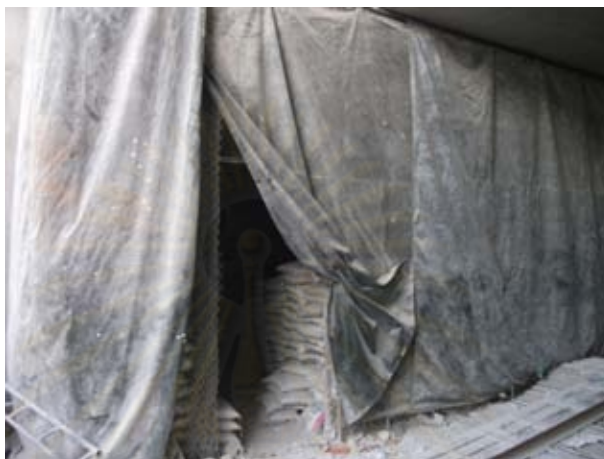
รูปที่ 4.14 แสดงการจัดทำสถานที่จัดเก็บวัสดุก่อสร้างที่ทำให้เกิดฝุ่นละออง ด้วยการใช้ผ้าใบที่คลุมทั้ง 4 ด้านของโครงการก่อสร้างที่ 2
