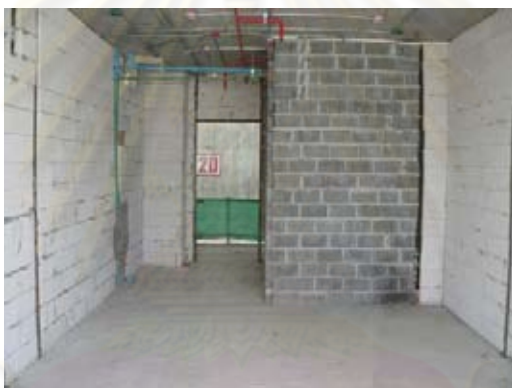
รูปที่ 4.20 แสดงงานก่ออิฐผนังห้องของโครงการก่อสร้างที่ 2
