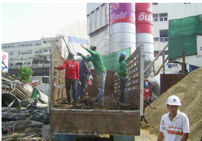
รูปที่ 4.30 แสดงการขนวัสดุก่อสร้างออกนอกโครงการของโครงการก่อสร้างที่ 1
