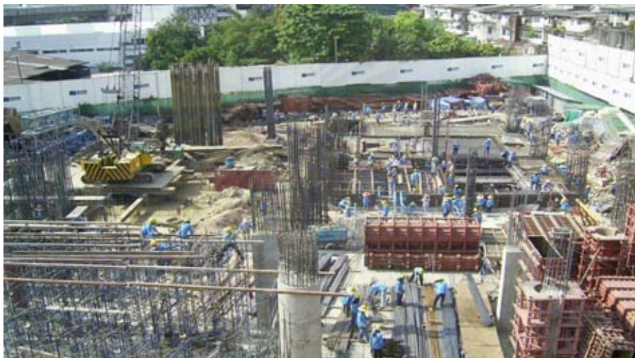
รูปที่ 4.16 แสดงพื้นที่ก่อสร้างของโครงการก่อสร้างที่ 1
