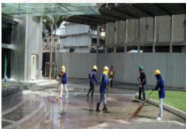
รูปที่ 4.11 แสดงการฉีดพรมน้ำและทำความสะอาดพื้นที่โครงการก่อสร้างที่ 2
