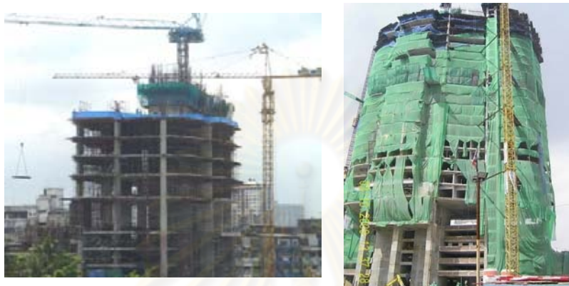
รูปที่ 4.4 แสดงการติดตั้งตาข่ายโครงการที่ 1
