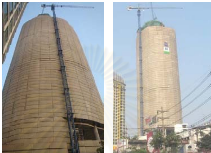
รูปที่ 4.5 แสดงการติดตั้งตาข่ายชนิดถี่โครงการก่อสร้างที่ 2
