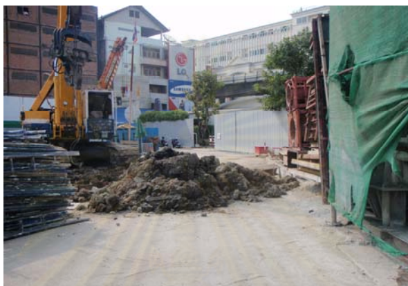
รูปที่ 4.10 แสดงพื้นที่ก่อสร้างที่ไม่ได้ฉีดพรมน้ำของโครงการก่อสร้างที่ 1
