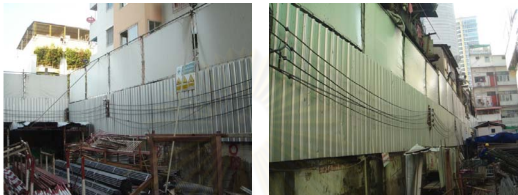
รูปที่ 4.3 แสดงการจัดทำรั้วทึบโครงการก่อสร้างที่ 3
