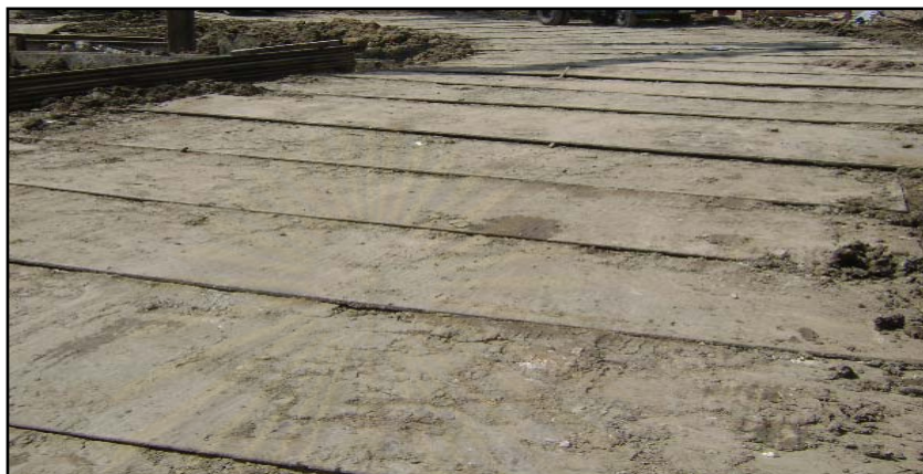
รูปที่ 4.39 แสดงการนำแผ่นเหล็กมาวางในพื้นที่ก่อสร้างของโครงการก่อสร้างที่ 3
