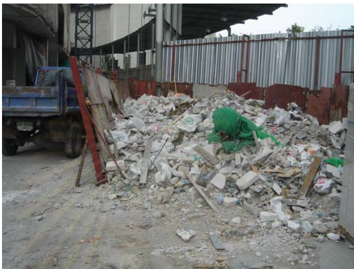
รูปที่ 4.31 แสดงการขนวัสดุก่อสร้างออกนอกโครงการของโครงการก่อสร้างที่ 2
