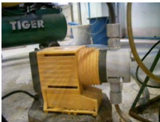
รูปที่ 3.3 เครื่องสูบน้ำเสียแบบไดอะแฟรมที่ใช้เป็นเครื่องสูบน้ำหมุนเวียนในระบบ
