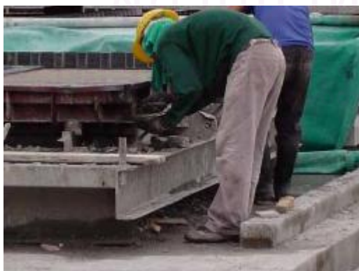
ภาพที่ 4.20 แสดงการประกอบแบบหล่อ
