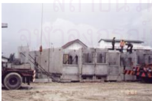
ภาพที่ 4.48 แสดงการติดตั้งชิ้นส่วนผนัง ชั้นล่างและพื้นชั้น 2
