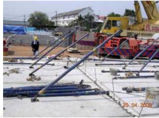
ภาพที่ 4.45 แสดงการติดตั้งป๊อบยึดผนัง
