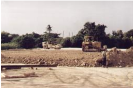
ภาพที่ 4.32 แสดงงานบดอัดดินใน
