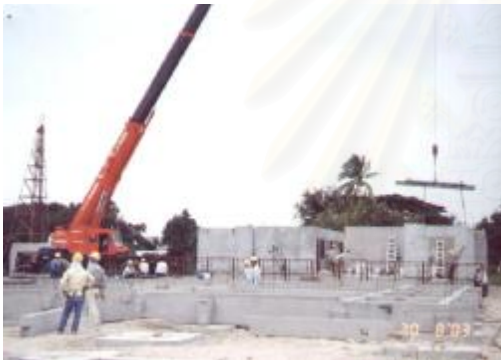
ภาพที่ 4.46 แสดงการติดตั้งชิ้นส่วน ผนังชั้นล่าง
