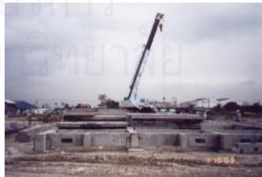
ภาพที่ 4.43 แสดงการติดตั้งชิ้นส่วน คานชั้นล่าง
