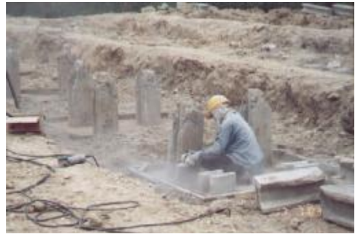
ภาพที่ 4.39 แสดงการตัดหัวเสาเข็ม
