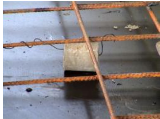
ภาพที่ 4.23 แสดงการหนุนเหล็กด้วยลูก
