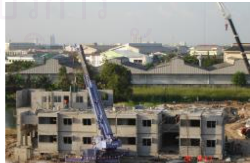
ภาพที่ 4.49 แสดงการติดตั้งชิ้นส่วน พื้นและผนังชั้น 3
