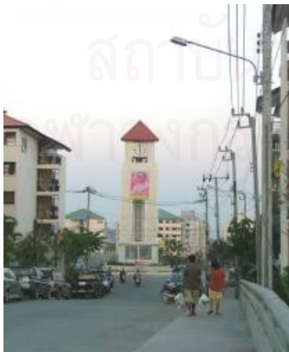
ภาพที่ 4.67 แสดงถนนและทางเท้า ในโครงการ
