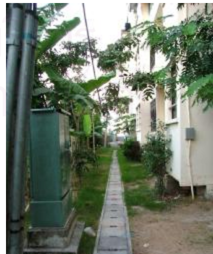
ภาพที่ 4.68 แสดงท่อระบายน้ำและ ทางเดินรอบอาคาร
