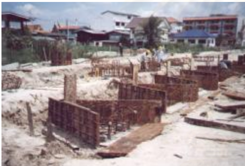
ภาพที่ 4.40 แสดงการเข้าแบบเหล็กหล่อ ฐานราก
