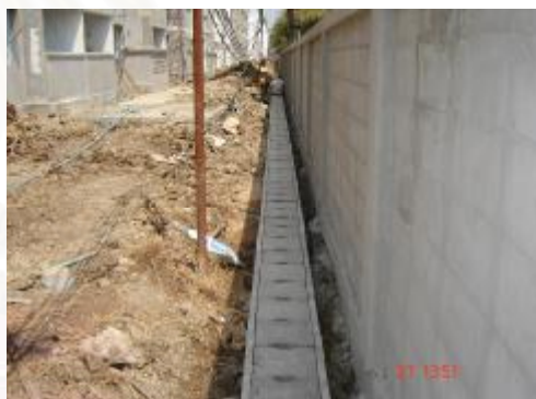
ภาพที่ 4.56 แสดงวางระบบน้ำรอบโครงการ
