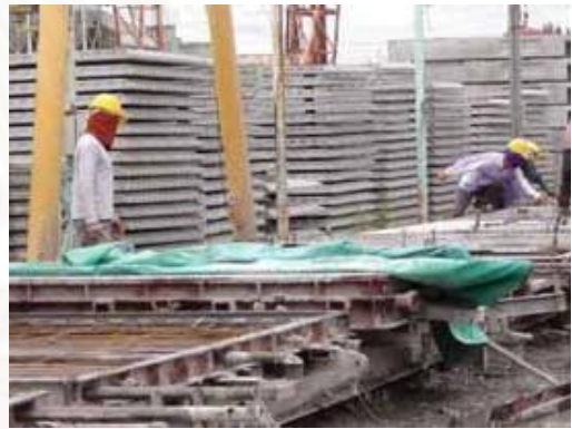
ภาพที่ 4.25 แสดงการบ่มคอนกรีตด้วย ผ้าใบคลุม
