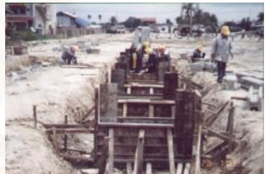
ภาพที่ 4.41 แสดงการเข้าแบบเหล็กหล่อ ฐานราก
