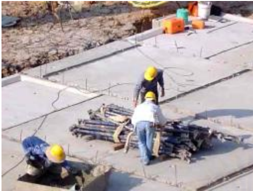
ภาพที่ 4.44 แสดงการติดตั้งชิ้นส่วน พื้นชั้นล่าง
