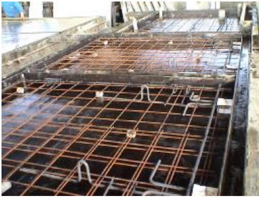
ภาพที่ 4.22 แสดงการใส่เหล็กโครงสร้าง
