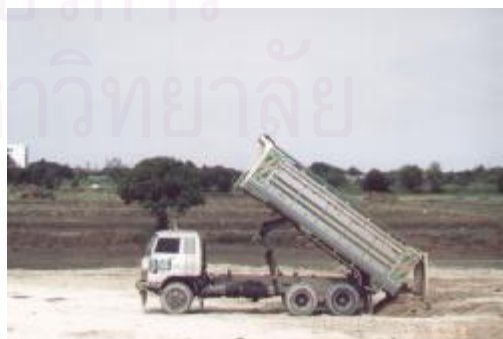
ภาพที่ 4.31 แสดงงานถมดินในโครงการ
