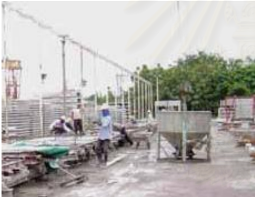
ภาพที่ 4.24 แสดงการเทคอนกรีตด้วย BUCKET
