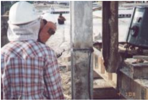
ภาพที่ 4.38 แสดงการเชื่อมต่อเสาเข็ม
