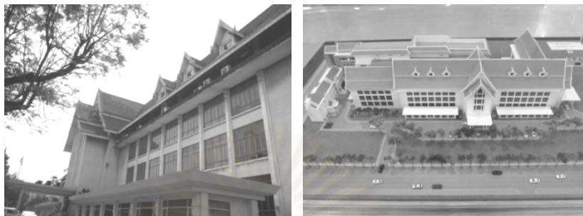
ภาพที่ 4.11 ภาพถ่ายภายนอกและหุ่นจำลองอาคารห้องสมุดประชาชนสวนลุมพินี
