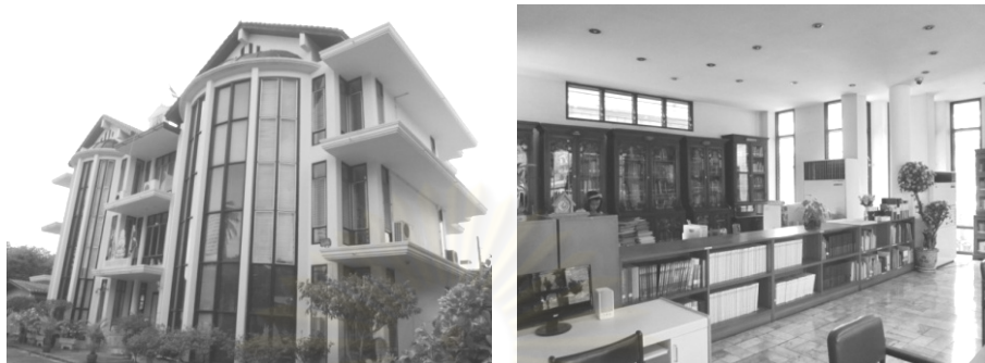
ภาพที่ 4.61 ภาพถ่ายภายนอกและภายในอาคารหอสมุดตำราโบราณภาพ
