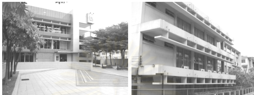
ภาพที่ 4.26 ภาพถ่ายภายนอกด้านหน้าและด้านหลังอาคารห้องสมุดฯซอยพระนาง
