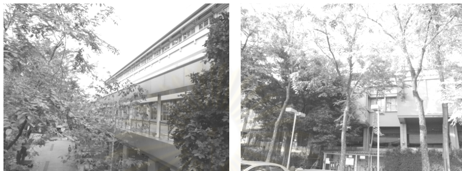
ภาพที่ 4.81 ภาพถ่ายภายนอกด้านหน้าและด้านหลังอาคาร
