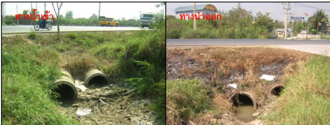
รูป 5.14 ตัวอย่างบริเวณที่มีการขยายขนาดท่อระบายน้ำ
