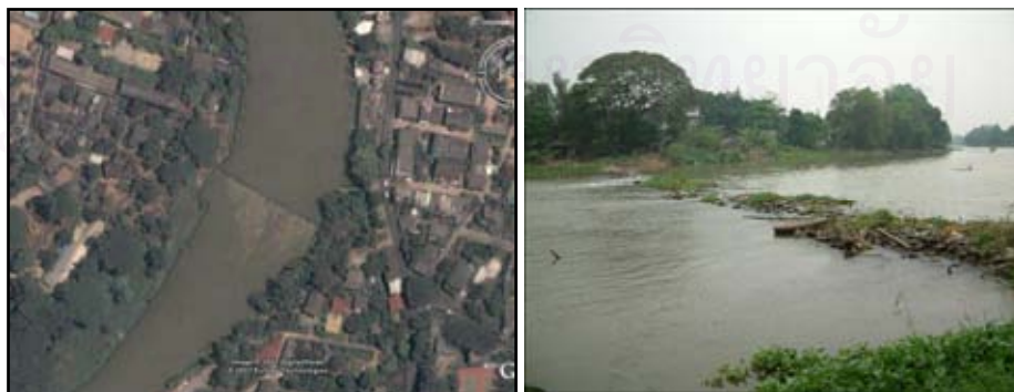
รูป 4.26 สภาพฝายกาวิละ บริเวณตำบลวัดเกต
