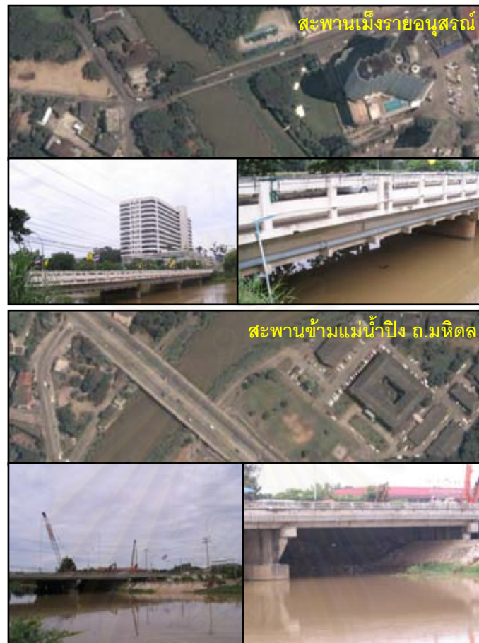
รูป 4.25 สภาพสะพานข้ามแม่น้ำปิงบริเวณทำนน้ำ จาก Google Earth และการสำรวจ
