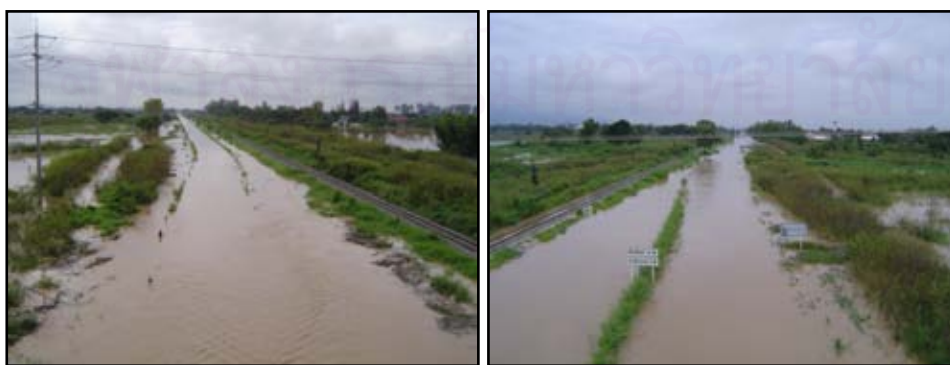
รูป 4.21 สภาพถนนเลียบบทางรถไฟ เชียงใหม่ – ลำพูน (Local Road) ขวางกั้นทางระบายน้ำ
