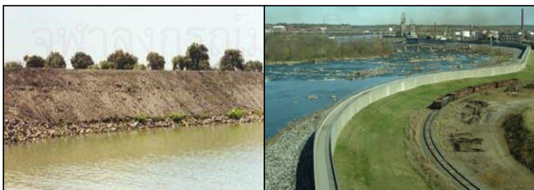
รูป 2.3 ตัวอย่างเขื่อนดินและกำแพงกั้นน้ำท่วม
