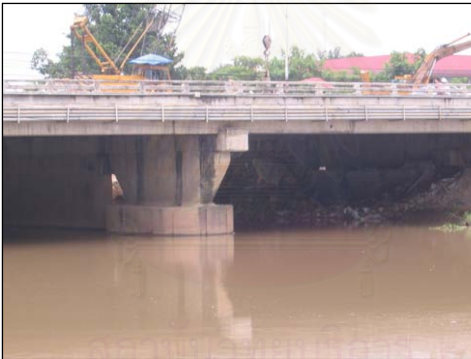
รูป 5.15 การขุดลอกขยายเพิ่มขนาดคอสะพาน บริเวณถนนมหิดล
