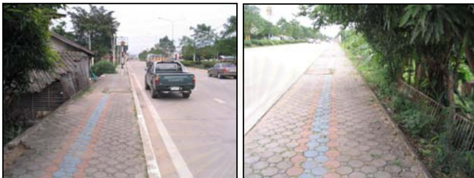
รูป 4.20 สภาพการสร้างถนนสูงกว่าที่อยู่อาศัยของประชาชน
