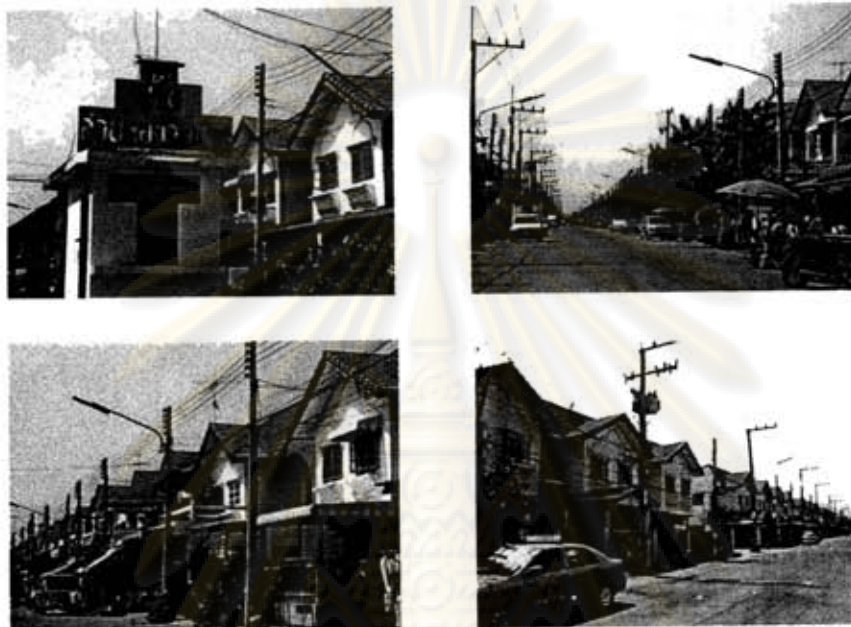
รูปที่ 3.3 สภาพปัจจุบันในหมู่บ้านฯ
