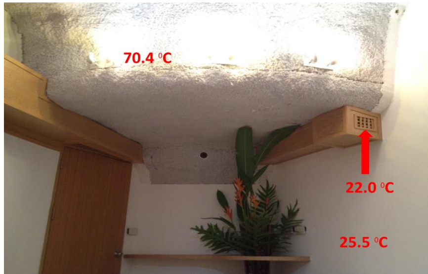
ภาพที่ 4.15 ห้องนวดน้ำมันสปาต้นแบบการวัดความเร็วลมหัวจ่ายแอร์ ณ.ดี เอน เอ วิสเซอร์ท แอนด์ สปาสร้างเสร็จสมบูรณ์
