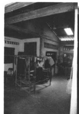
ครัวที่ต่อเติมใหม่
