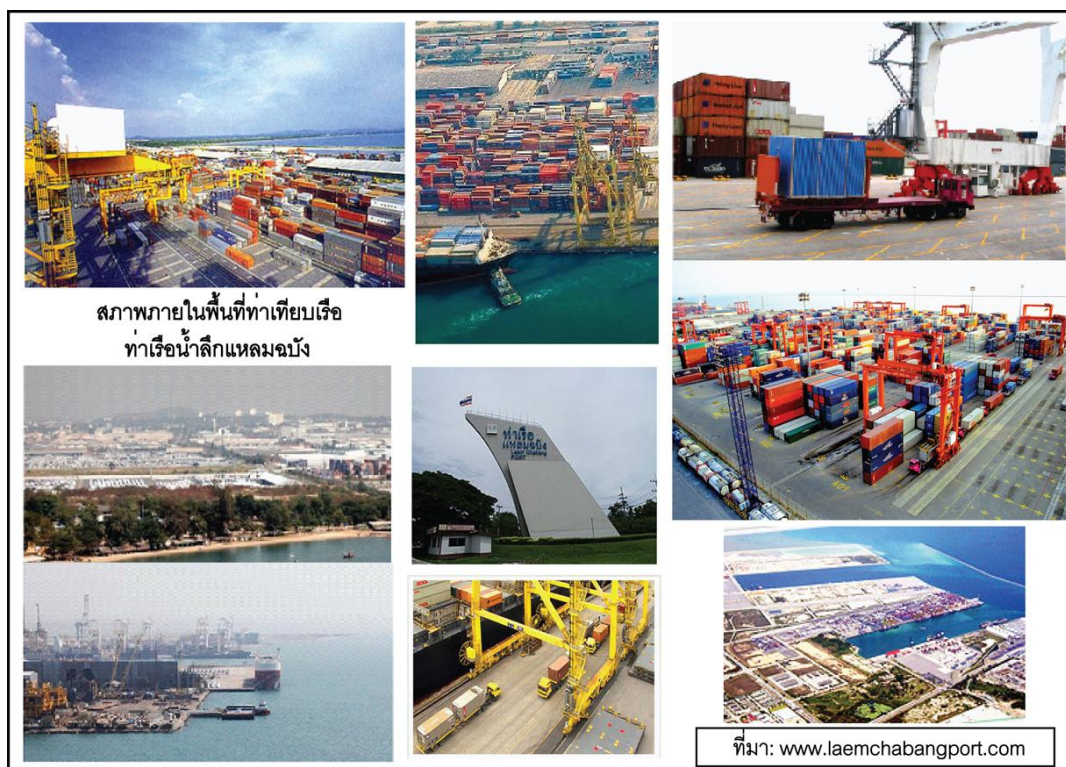
ภาพที่ 4.5 สภาพภายในพื้นที่ท่าเทียบเรือ ท่าเรือน้ำลึกแหลมฉบัง
