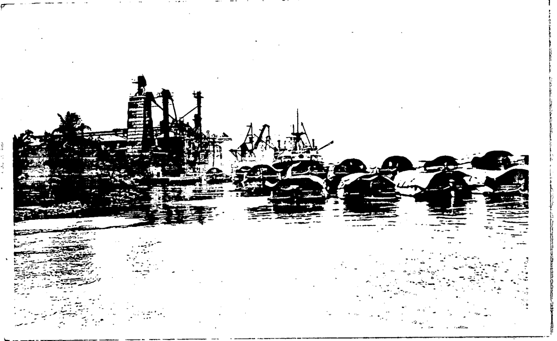
โรงงานที่อยู่ริมแม่น้ำใช้ปั้นจั่นในการขนถ่ายวัสดุดิบจาก เรือ
