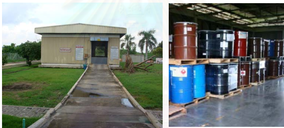
รูปที่ 4.6 บริเวณอาคารเก็บสารเคมี
