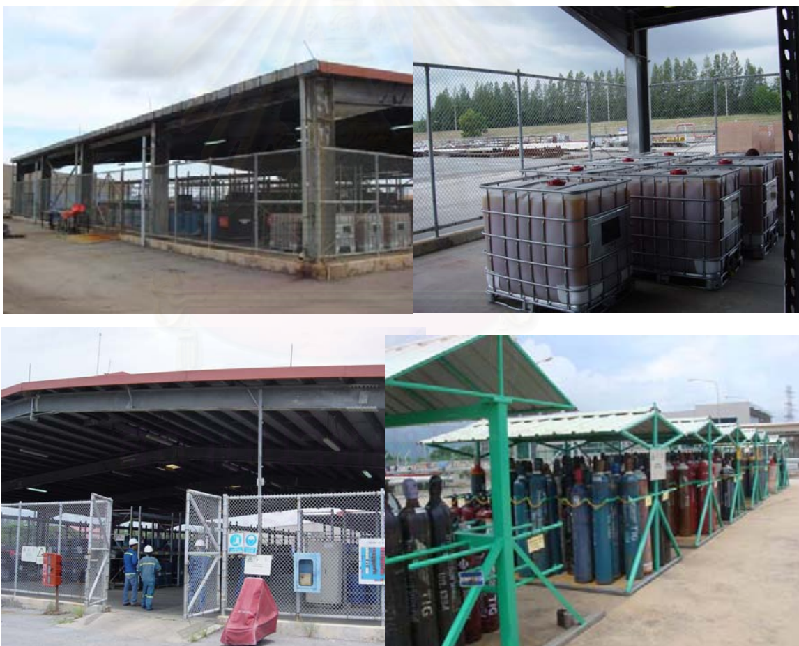
รูปที่ 4.1 บริเวณอาคารเก็บสารเคมี
