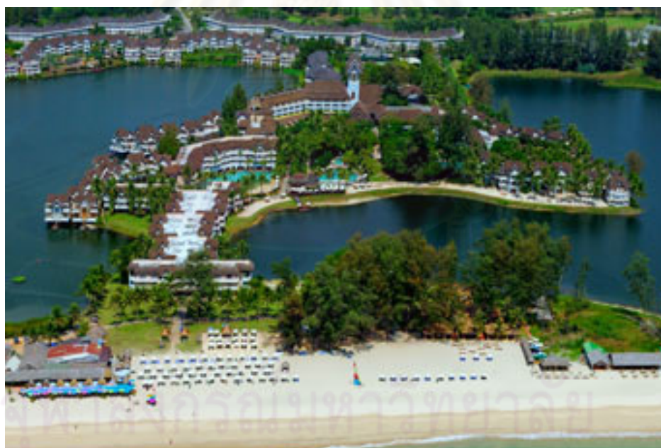
ภาพที่ 19 ภาพแสดงโครงการ Sheraton Grande Laguna Phuket
