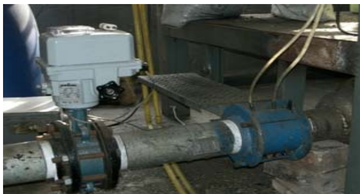
ภาพที่ 3.4 วาล์วไฟฟ้ารูปผีเสื้อและ Orifice
