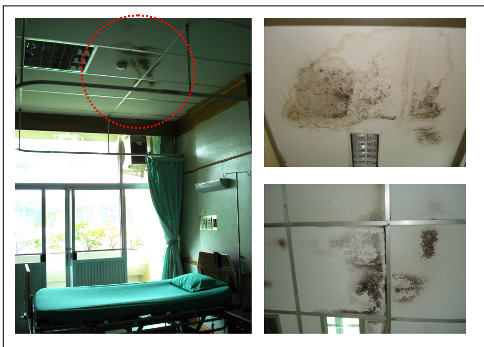
ภาพที่ 4.2 ฝ้าเพดานเป็นเชื้อราแบบเป็นจุด
