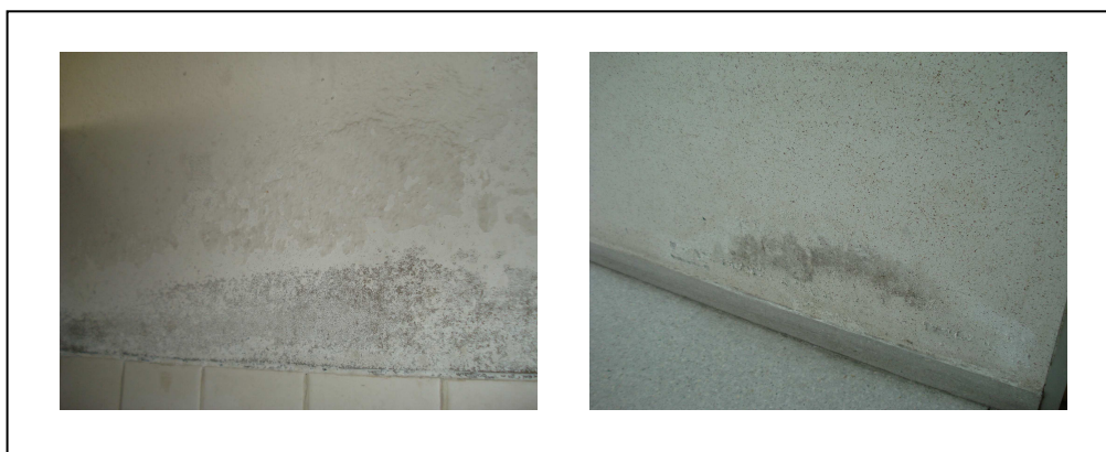
ภาพที่ 4.9 ลักษณะของผนังมีคราบเกลือ สีและปูนยุ่ยเป็นผง
