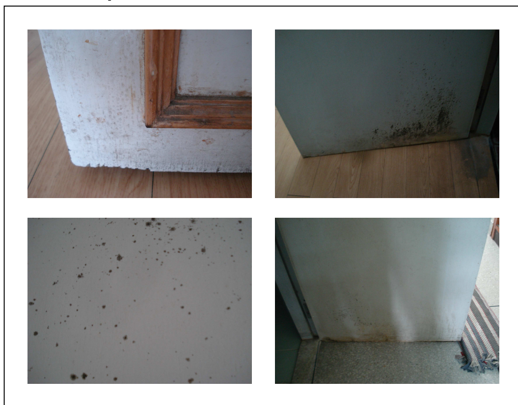
ภาพที่ 4.17 สภาพประตูเป็นเชื้อรา
