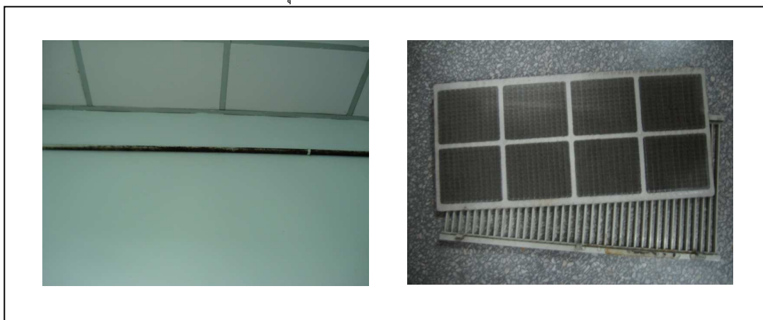
ภาพที่ 4.26 สภาพฟิลเตอร์หรือท่อน้ำทิ้งอุดตัน
