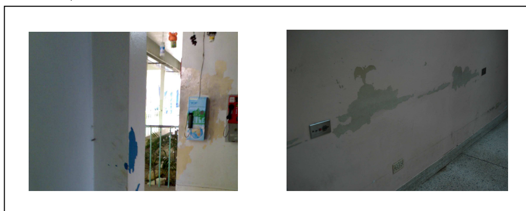
ภาพที่ 4.7 สีหลุดร่อนเป็นแผ่นใหญ่
