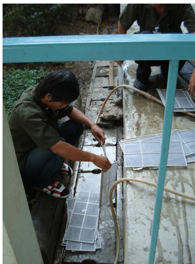
ภาพที่ 3.3 การปฏิบัติงานการล้างฟิลเตอร์ด้วยน้ำ
