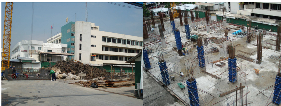
ภาพที่ 3.1 อาคารที่กำลังก่อสร้าง สูง 8 ชั้นอยู่บริเวณหน้าโรงพยาบาล
