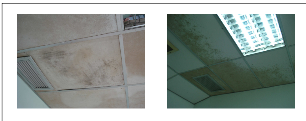
ภาพที่ 4.1 ฝ้าเพดานเป็นเชื้อราทั้งห้อง หรือเกือบทั้งห้อง
