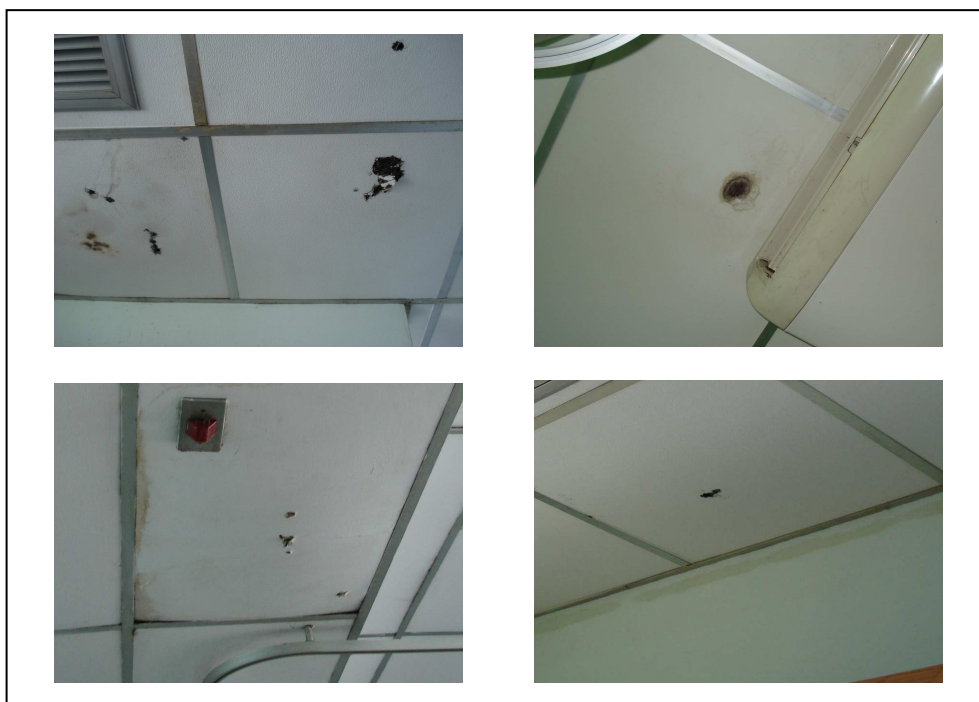
ภาพที่ 4.3 เนื้อแผ่นฝ้าเพดานยุบเหลือเพียงเส้นใยของฝ้า
