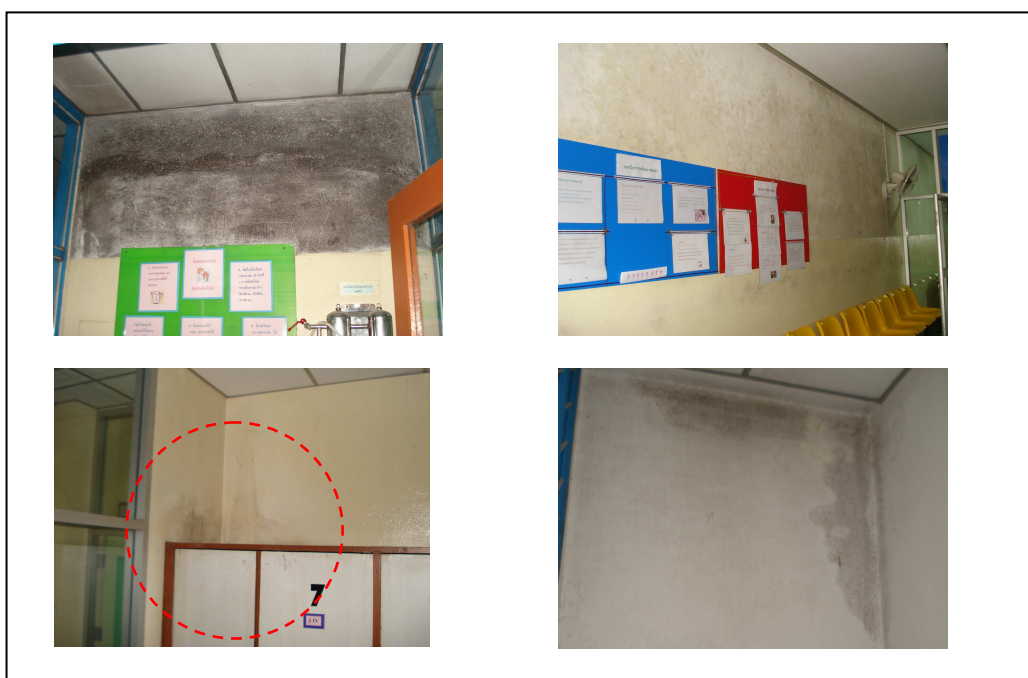
ภาพที่ 4.10 ผนังมีคราบรอยดำของเชื้อรา
