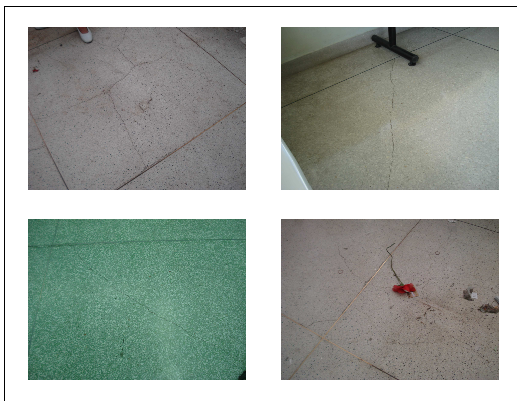
ภาพที่ 4.13 สภาพพื้นหินขัดมีรอยแตกกร้าว
