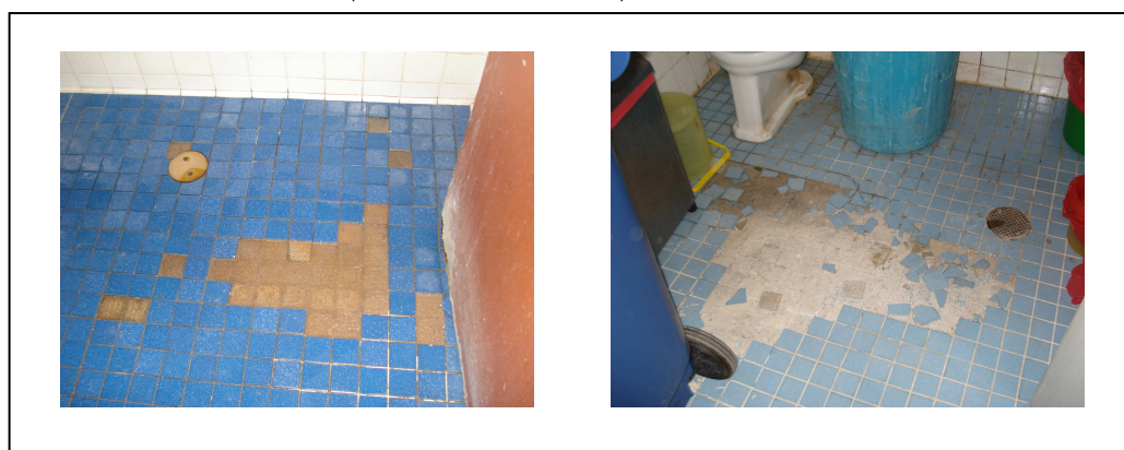
ภาพที่ 4.14 สภาพพื้นกระเบื้องหลุดร่อน และมีรอยแตกชำรุดร่วมด้วย
