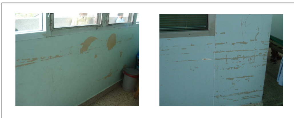
ภาพที่ 4.8 สีหลุดร่อนเป็นแผ่น และมีรอยขีดข่วน
