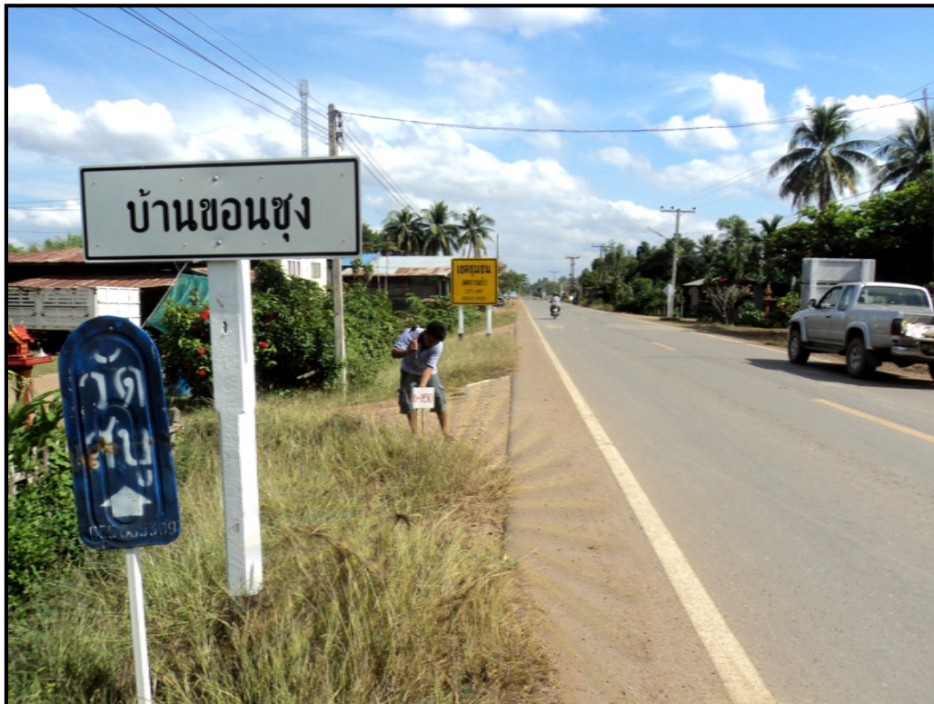
รูปที่ 3.10 การติดตั้งป้ายบอกระยะทางทุกๆ 25 เมตร
