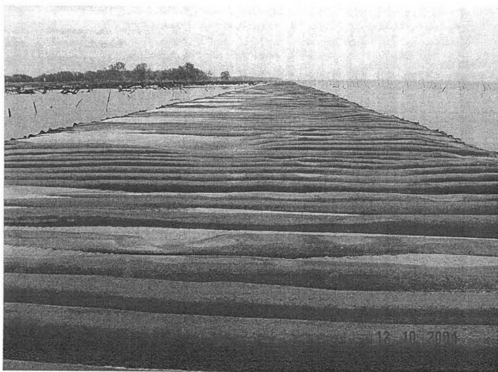
รูป ง-4 แสดง Apron ขณะทำการก่อสร้างเสร็จแล้ว
