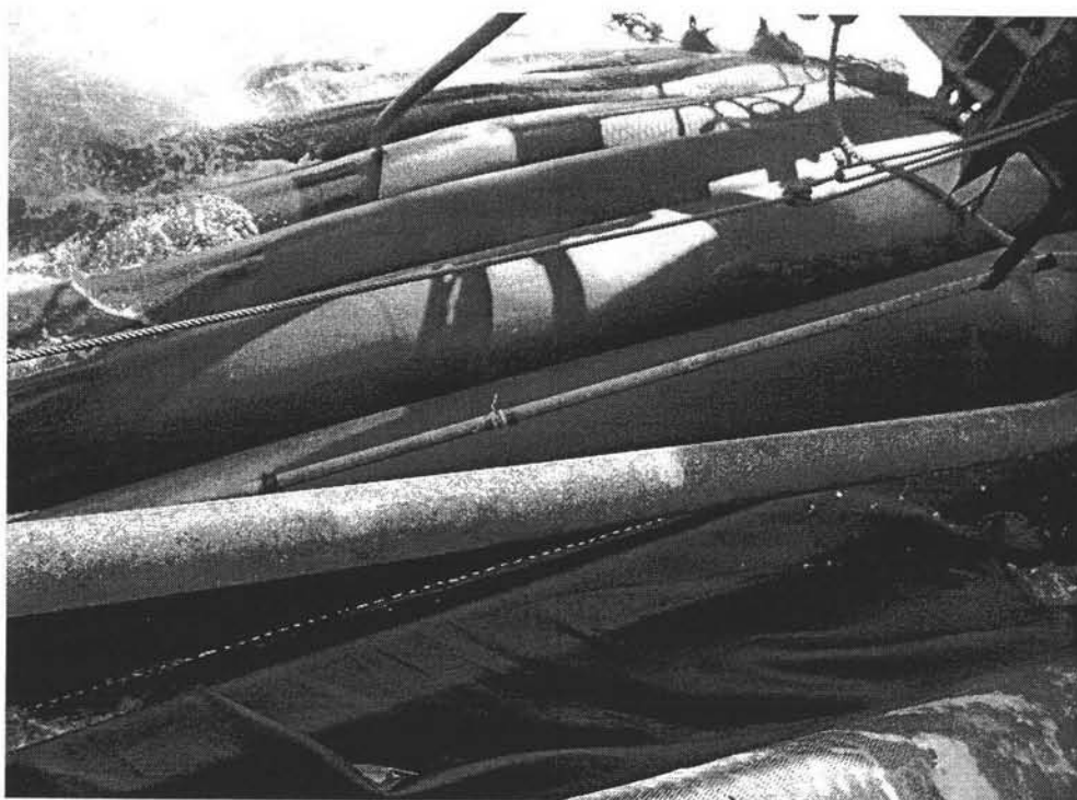
รูป ง-6 แสดง การก่อสร้าง Apron โดยการใส่ทรายเข้าไปใน geotextile
