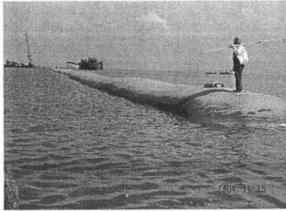
รูปที่ 3.14 ช่างสำรวจใช้ไม้วัดระดับในการวัดระดับ
