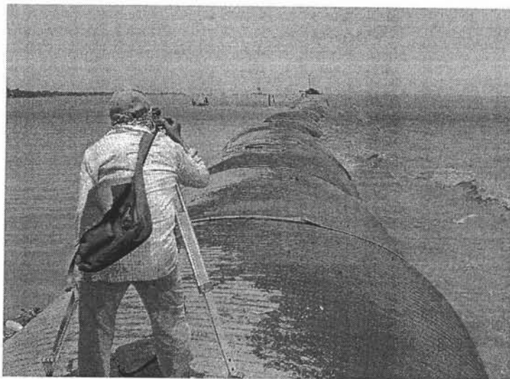
รูปที่ 3.12 ช่วงสำรวจใช้กล้องวัดระดับในการวัดระดับการทรุดตัวของ GEOTUBE
