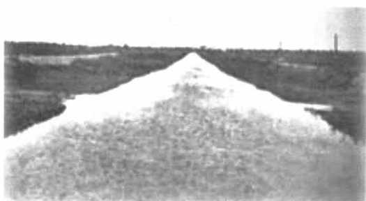
รูปภาพ 2 -20 คลองส่งน้ำจากเชียงรากถึงกรุงเทพฯ ตามโครงการจัดหาน้ำบริโภค และประตุระบายน้ำที่สามเสนสำหรับระบายน้ำไปสู่ที่สูบน้ำเพื่อจัดทำน้ำประปา
