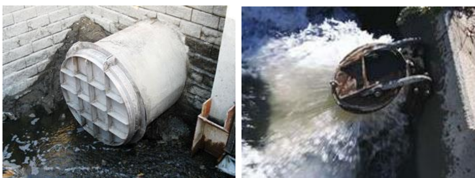
ภาพที่ 2.23 แสดงลักษณะการทำงานของบานประตูกันน้ำไหลย้อนกลับอัตโนมัติ (Flap Gate) แบบที่ติดตั้งที่ปลายท่อ
