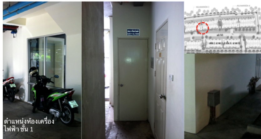
ภาพที่ 5.64 แสดงรูปภาพโครงการ ซิตีโฮม รัชดา-ปิ่นเกล้าภายหลังจากน้ำท่วมปี พ.ศ. 2554
