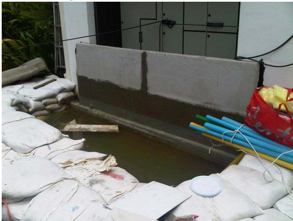
ภาพที่4.101รูปภาพเหตุการณ์อุทกภัย วันที่ 04พฤศจิกายน พ.ศ.2554 มีการป้องกันด้วยแนวกำแพงกันพื้นที่ส่วนห้องเครื่องบริเวณชั้น 1 ของโครงการ
