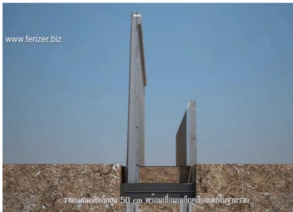
ภาพที่ 2.12 แสดงการก่อสร้างรั้ว 2 ชั้น โดยชั้นแรกสูง 2.75 ม. และชั้นที่ 2 สูง 0.50 ม.
