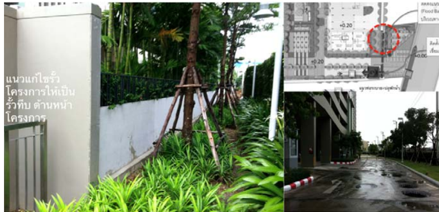
ภาพที่ 5.43 แสดงรูปภาพโครงการ ลุมพินีพาร์คปิ่นเกล้าภายหลังจากน้ำท่วมปี พ.ศ. 2554
