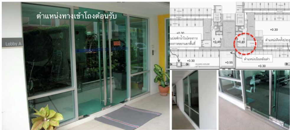
ภาพที่ 5.32 แสดงรูปภาพโครงการ มายคอนโดลาดพร้าว 27 ภายหลังจากน้ำท่วมปี พ.ศ. 2554
