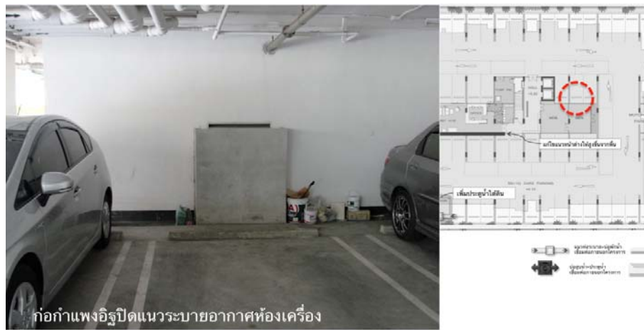
ภาพที่ 5.14 แสดงรูปภาพโครงการ ทรี คอนโดลาดพร้าว 27 ภายหลังจากท่วมปี พ.ศ. 2554
