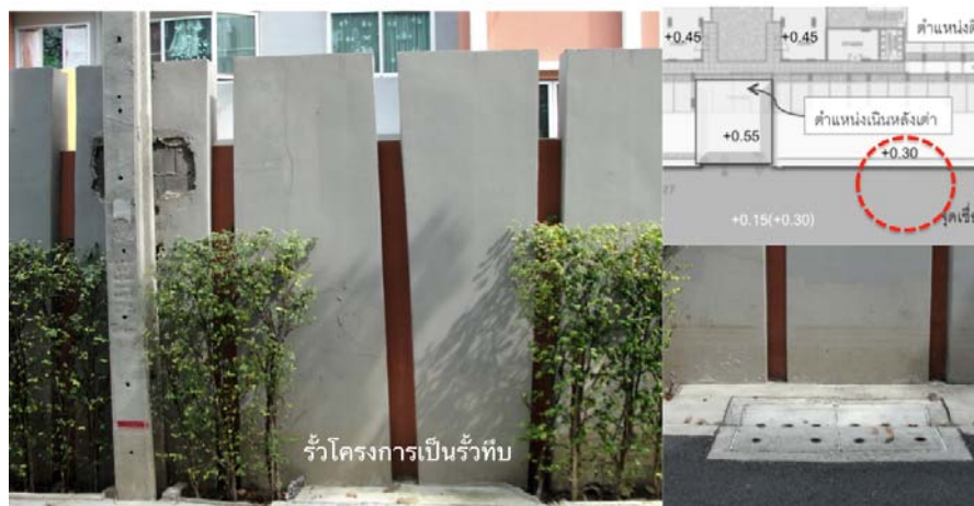
ภาพที่ 5.22 แสดงรูปภาพโครงการ มายคอนโดลาดพร้าว 27 ภายหลังจากน้ำท่วมปี พ.ศ. 2554
