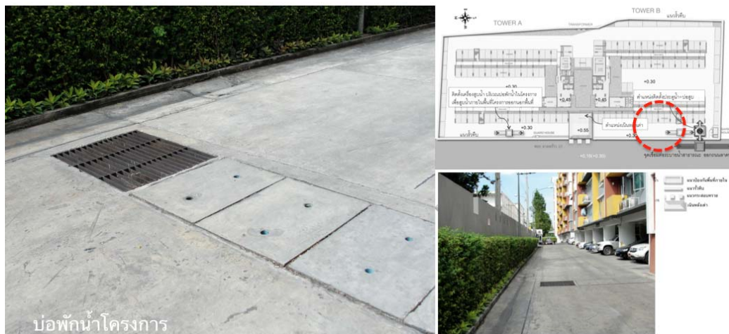
ภาพที่ 5.35 แสดงรูปภาพโครงการ มายคอนโดลาดพร้าว 27 ภายหลังจากน้ำท่วมปี พ.ศ. 2554
