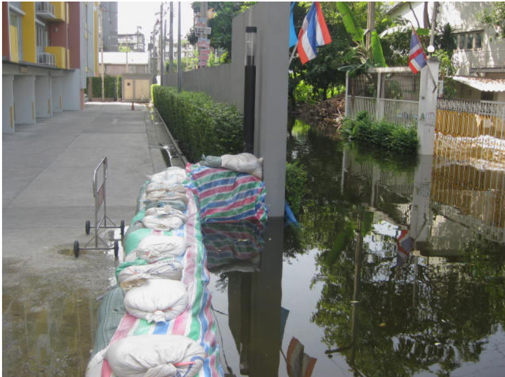
ภาพที่4.38รูปภาพเหตุการณ์อุทกภัย วันที่ 17พฤศจิกายน พ.ศ.2554 แนวกันน้ำบริเวณทางเข้าโครงการ เหนือเนินยกระดับ เพื่อเสริมแนวป้องกัน
