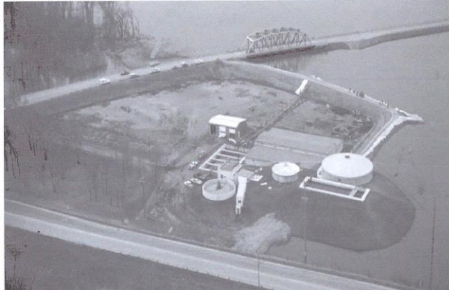
ภาพที่ 2.1 แสดงการก่อสร้างคันดินกันน้ำ การทำคันกันน้ำป้องกันน้ำท่วม
