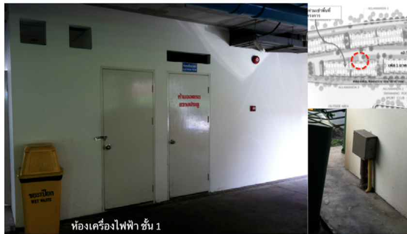
ภาพที่ 5.67 แสดงรูปภาพโครงการ ซิตีโฮม รัชดา-ปิ่นเกล้าภายหลังจากน้ำท่วมปี พ.ศ. 2554
