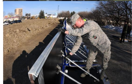
ภาพที่ 2.17 แสดงแนวทางกันน้ำแบบรั้วชั่วคราว
