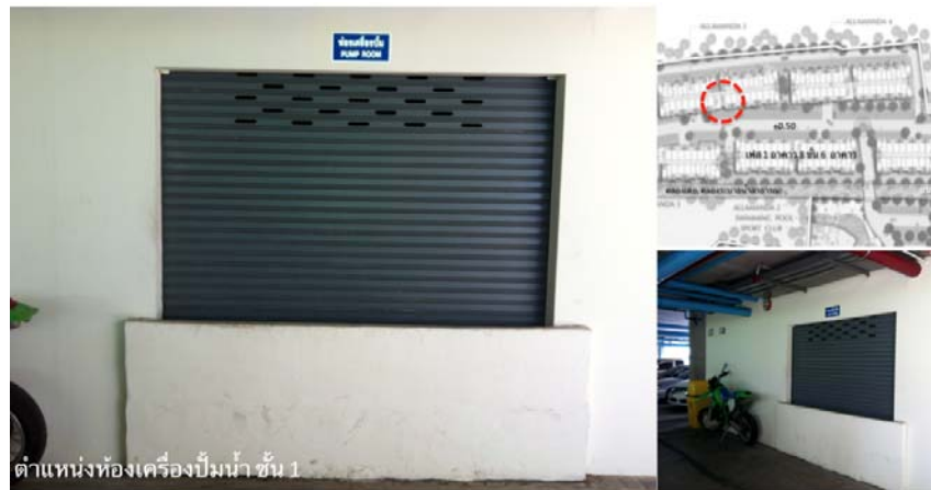
ภาพที่ 5.65 แสดงรูปภาพโครงการ ซิตีโฮม รัชดา-ปิ่นเกล้าภายหลังจากน้ำท่วมปี พ.ศ. 2554
