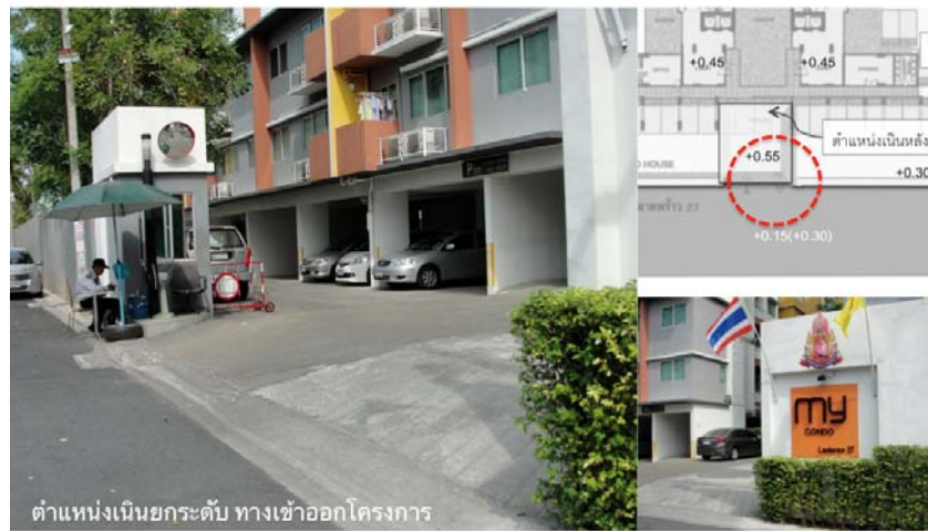
ภาพที่ 5.23 แสดงรูปภาพโครงการ มายคอนโดลาดพร้าว 27 ภายหลังจากน้ำท่วมปี พ.ศ. 2554
