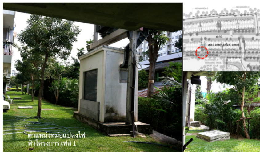
ภาพที่ 5.68 แสดงรูปภาพโครงการ ซิตีโฮม รัชดา-ปิ่นเกล้าภายหลังจากน้ำท่วมปี พ.ศ. 2554
