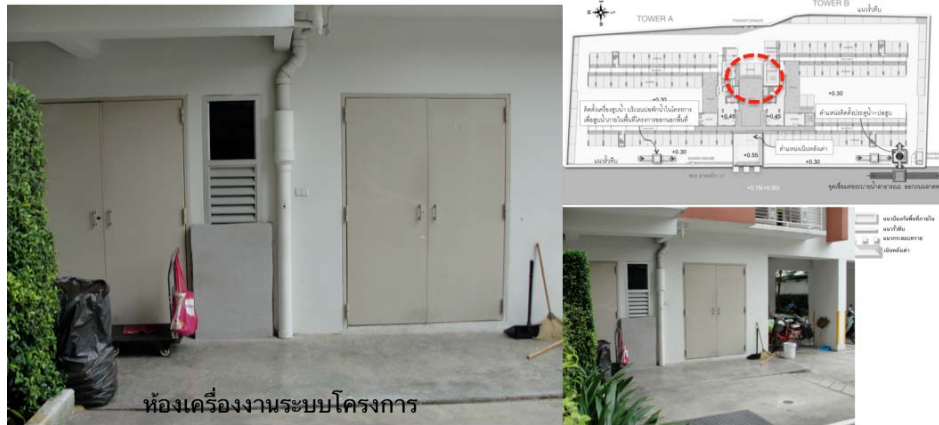
ภาพที่ 5.29 แสดงรูปภาพโครงการ มายคอนโดลาดพร้าว 27 ภายหลังจากน้ำท่วมปี พ.ศ. 2554
