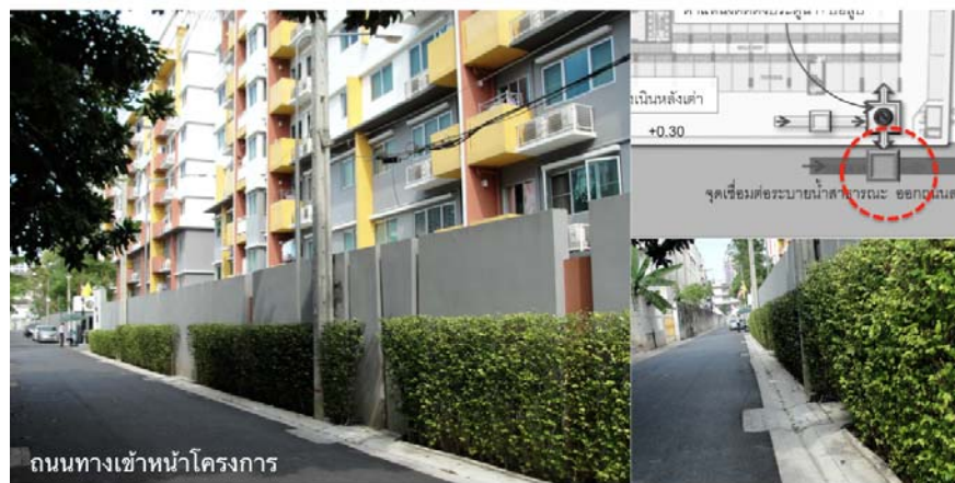
ภาพที่ 5.21 แสดงรูปภาพโครงการ มายคอนโดลาดพร้าว 27 ภายหลังจากน้ำท่วมปี พ.ศ. 2554
