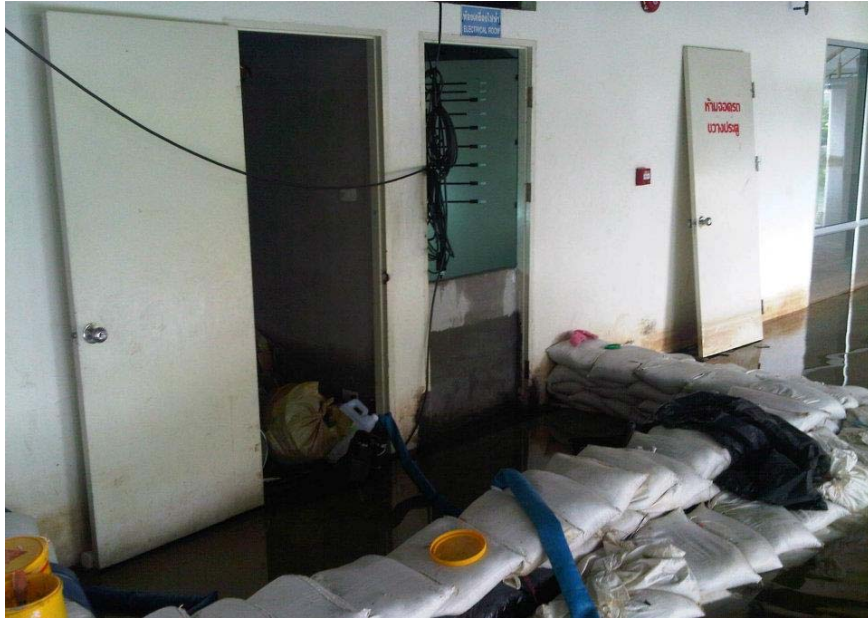
ภาพที่4.98รูปภาพเหตุการณ์อุทกภัย เฟส 2 วันที่ 04พฤศจิกายน พ.ศ.2554 มีการป้องกันด้วยแนวกระสอบทราย เป็นชั้นตามแนว โดยกันแนวป้องกันเป็นแบบแก้มลิง บริเวณพื้นที่ต่อเนื่องเข้าไปภายในอาคารและห้องเครื่องทั้งหมด
