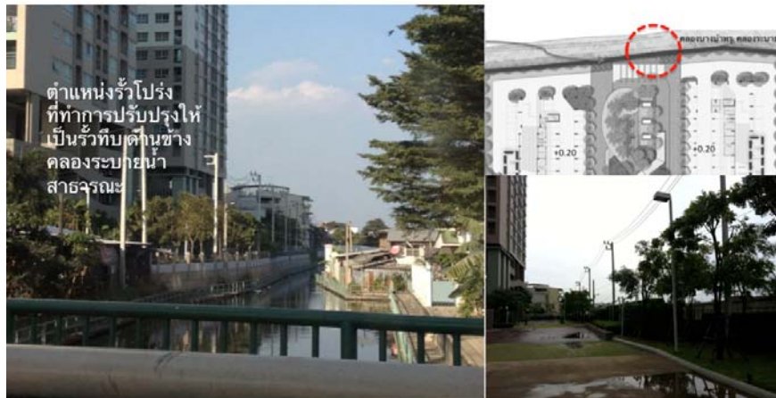
ภาพที่ 5.46 แสดงรูปภาพโครงการ ลุมพินีพาร์คปิ่นเกล้าภายหลังจากน้ำท่วมปี พ.ศ. 2554
