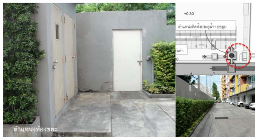
ภาพที่ 5.25 แสดงรูปภาพโครงการ มายคอนโดลาดพร้าว 27 ภายหลังจากน้ำท่วมปี พ.ศ. 2554
