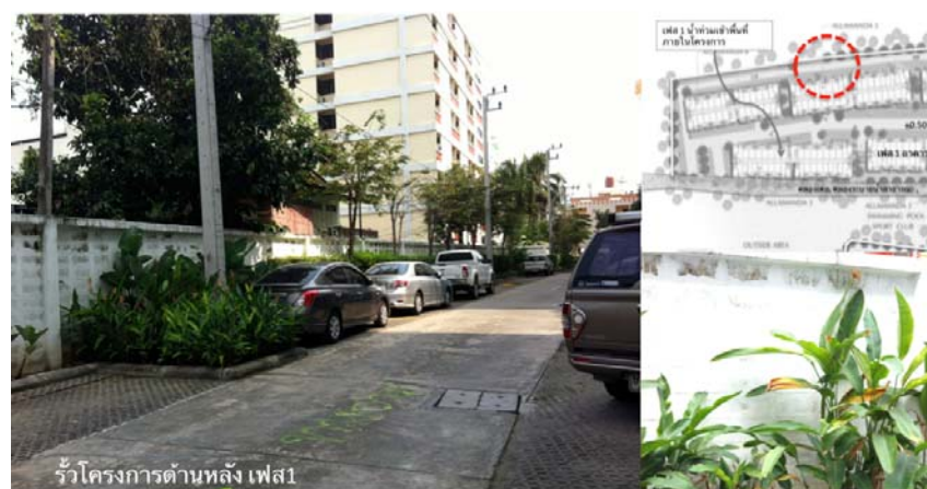
ภาพที่ 5.66 แสดงรูปภาพโครงการ ซิตีโฮม รัชดา-ปิ่นเกล้าภายหลังจากน้ำท่วมปี พ.ศ. 2554
