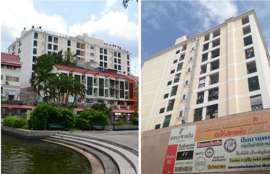
ภาพที่ 4.8 ภาพถ่ายอาคารพักอาศัย (ที่มา : ผู้วิจัย)
