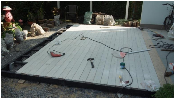
รูปภาพที่ 5.25 แสดงลักษณะการก่อสร้างส่วนที่ต่อเติม
