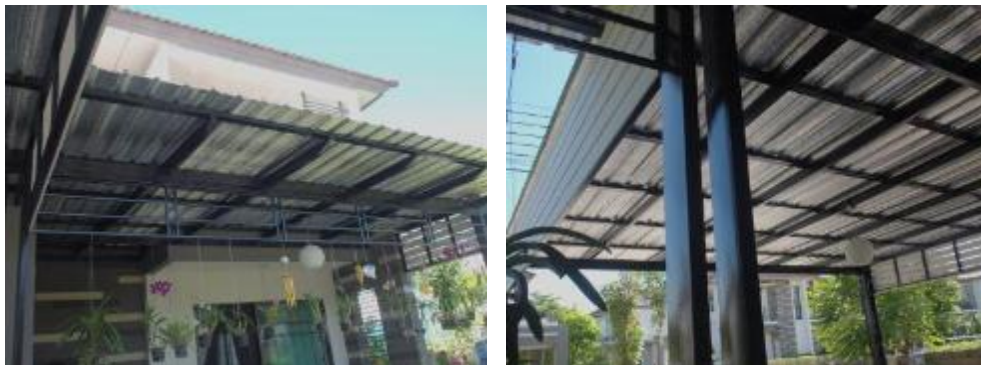
รูปภาพที่ 4.4 อันดับที่ 3 ต่อเติมหลังคาโรงจอดรถ
