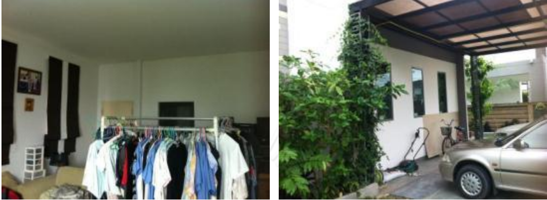
รูปภาพที่ 4.62 อันดับที่ 2 ต่อเติมปิดโรงรถเป็นห้องเอนกประสงค์
