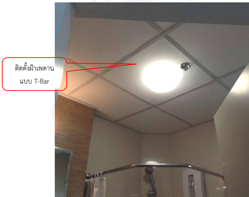
รูปภาพที่ 5- 7 เปลี่ยนฝ้าแบบฉาบเรียบเป็นฝ้าเพดานแบบ T-Bar (จากตารางที่ 5-3 )
