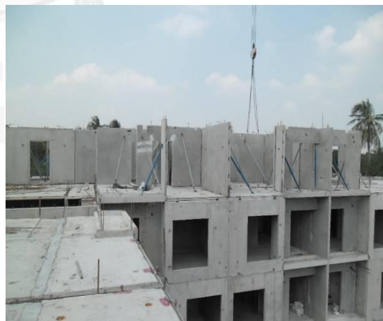
รูปภาพที่ 5- 14 งานปรับเปลี่ยนโครงสร้างระบบ Tunnel Form (จากตารางที่ 5-11)
