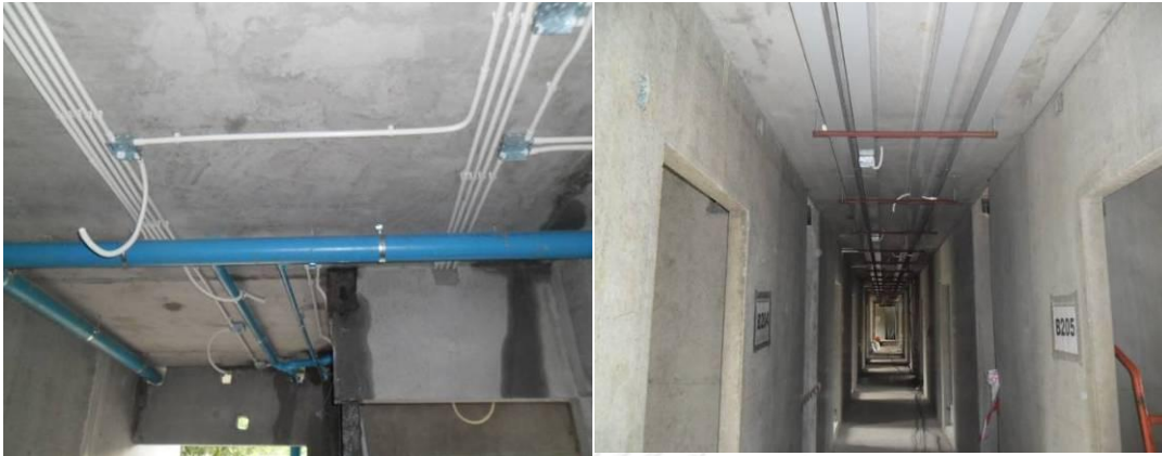
รูปภาพที่ 5- 20 ภาพถ่ายแสดงการติดตั้งระบบไฟฟ้าภายในอาคาร
