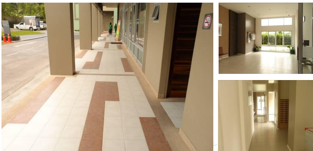
รูปภาพที่ 5- 24 การเปลี่ยนกระเบื้องปูพื้นขนาด 0.60X0.60 ซม. บริเวณภายในทางเดินส่วนกลาง (จากตารางที่ 5-15)
