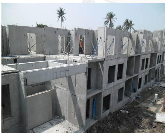
รูปภาพที่ 5- 14 งานปรับเปลี่ยนโครงสร้างระบบ Tunnel Form (จากตารางที่ 5-11)
