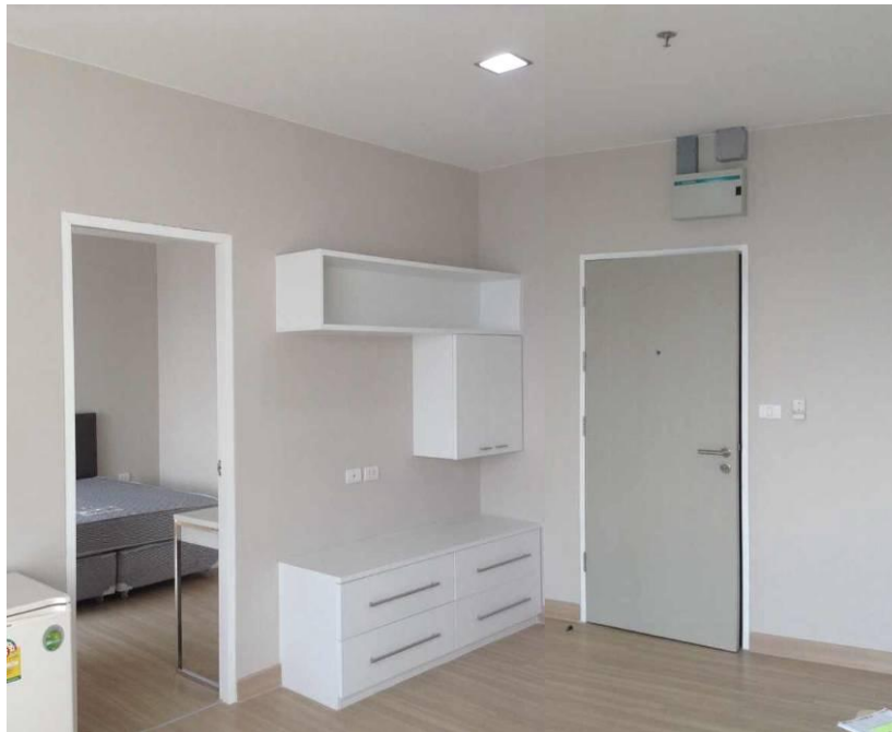
รูปภาพที่ 5- 4 วงกบประตูโดยจากแบบที่ระบุเป็นแบบวงกบแห้ง (จากตารางที่ 5-3 )
