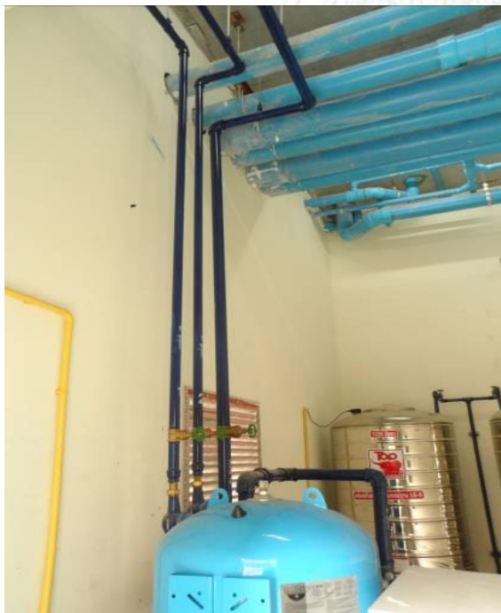
รูปภาพที่ 5- 28 การใช้ท่อกัลวาไนซ์ 4-5 ชั้น สุกท้ายก่อนจ่ายน้ำเข้าห้องเครื่องปั้มน้ำแรงดันสูง (จากตารางที่ 5-15)
