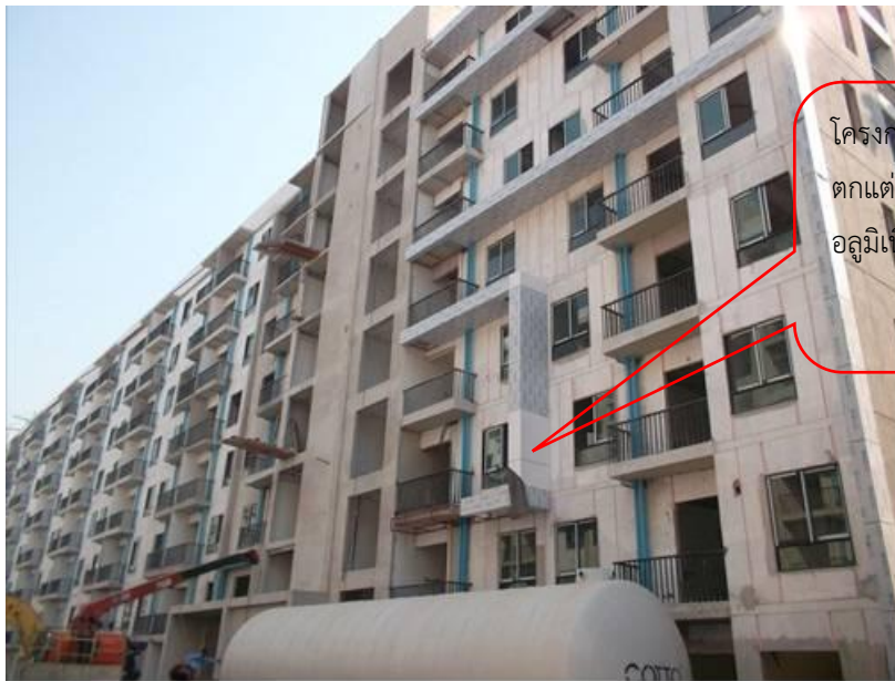
รูปภาพที่ 5- 17 รูปถ่ายด้านหน้าอาคารชุดพักอาศัยโครงการเดิมของบริษัทที่ครีบอลาคาร์ตกแต่งด้วยแผ่น อลูมิเนียมคอมโพสิต
