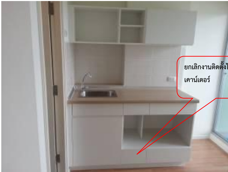
รูปภาพที่ 5- 26 การยกเลิกงานติดตั้งพื้นไม้สำเร็จรูปใต้เคาน์เตอร์เตรียมอาหาร (จากตารางที่ 5—15)
