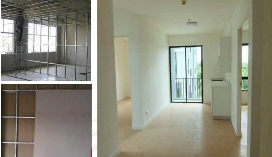
รูปภาพที่ 5- 22 การเปลี่ยนผนัง กั้นตู้เสื้อผ้าและกั้นห้องนอนจากแผ่นคอนกรีตสำเร็จรูปเป็นผนังเบาสำเร็จรูป ชุบสังกะสี (จากตารางที่ 5-11)
