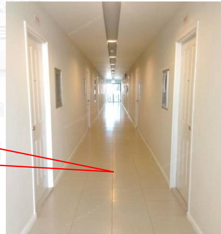
รูปภาพที่ 5- 21 การเปลี่ยนกระเบื้องปูพื้นขนาด 0.60X0.60 ซม. บริเวณภายในทางเดินส่วนกลางของโครงการเดิม มาเป็น (จากตารางที่ 5-11)
