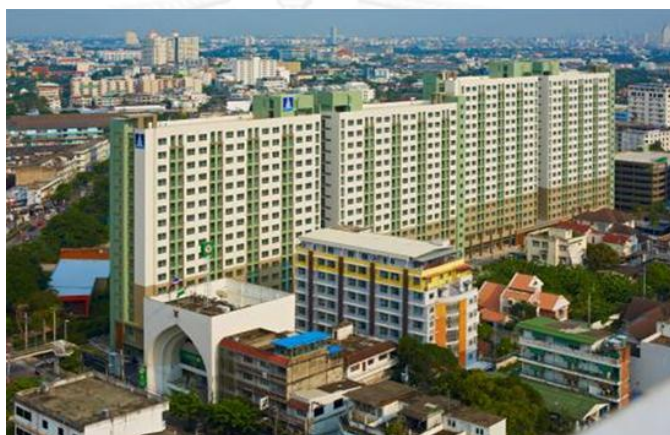
รูปภาพที่ 3- 3 ทศนิยมภาพ อาคารชุดพักอาศัย ( ลุมพินี วิลล์ สุขุมวิท 77)
