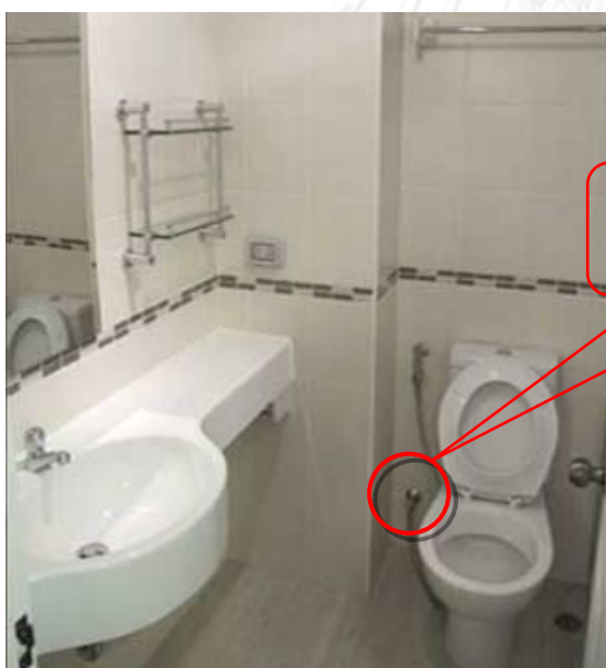
รูปภาพที่ 5- 25 การยกเลิกชนิดวาล์วปิด-เปิดน้ำชนิด 2 ทางเป็นชนิด 1 ทางที่สายชำระ (จากตารางที่ 5-15)
