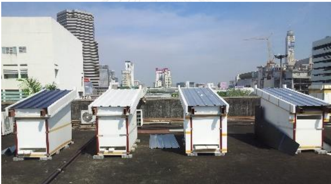
ภาพที่ 3 - 7 กล่องทดลองทั้งสี่กล่องก่อนปิดแผงกันลม
