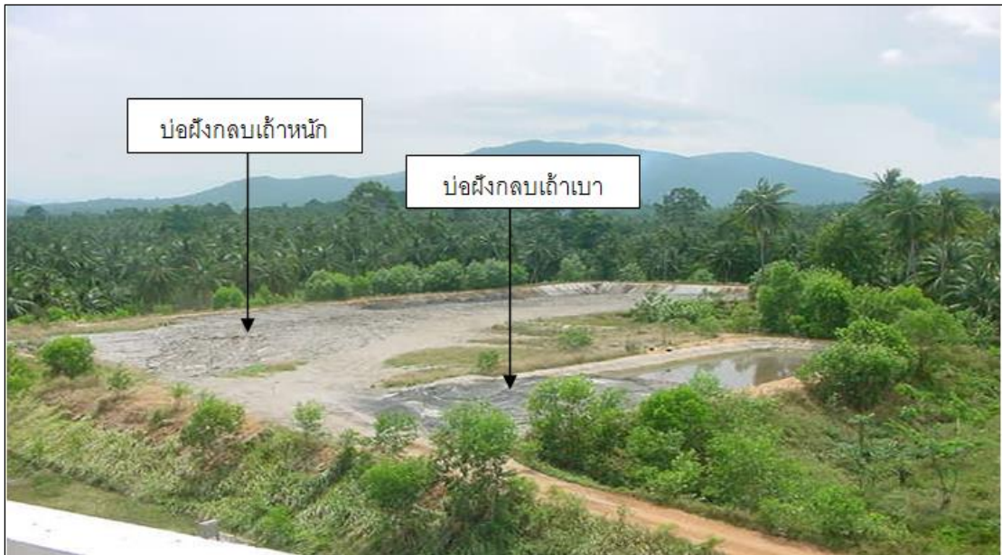
รูปที่ 4.4 พื้นที่บ่อฝังกลบเถ้าหนักและบ่อฝังกลบเถ้าเบา [13]
