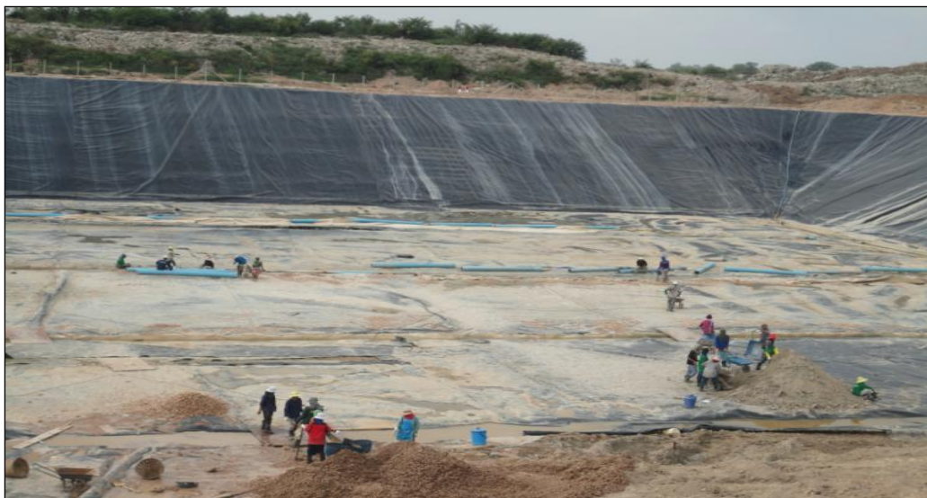
รูปที่ 4.12 บ่อฝังกลบขยะแบบถูกสุขลักษณะของเทศบาลนครนครราชสีมา[14]
