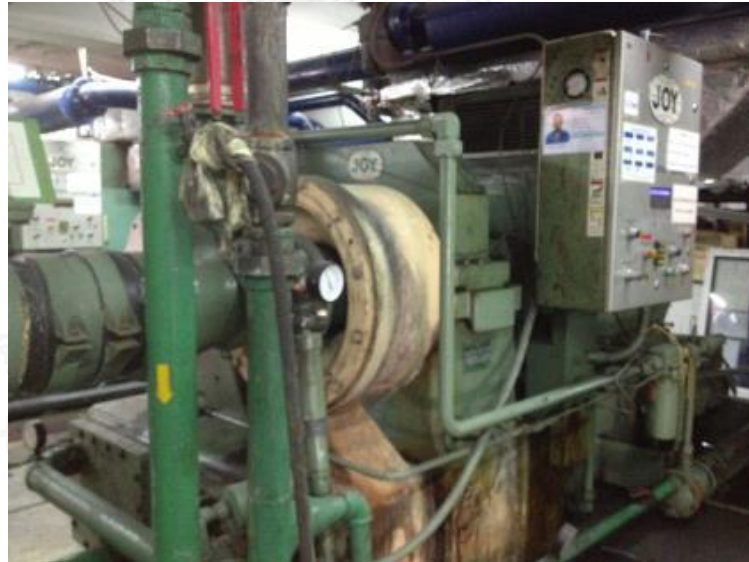
รูปที่ 4.11 เครื่องอัดอากาศ (Air Compressor) เครื่องที่ 2 JOY TA-38 (Turbo)
