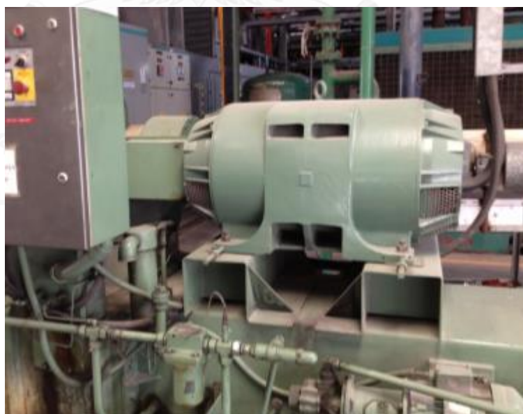
รูปที่ 4.19 เครื่องอัดอากาศ (Air Compressor) เครื่องที่ 10 JOY TA-18 (Turbo)
