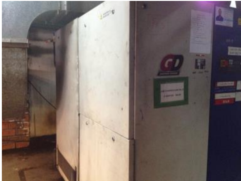
รูปที่ 4.24 เครื่องอัดอากาศ (Air Compressor) เครื่องที่ 15 Gardner ROL-120 (Rotary Vane)
