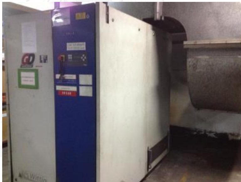
รูปที่ 4.23 เครื่องอัดอากาศ (Air Compressor) เครื่องที่ 14 Gardner ROL-120 (Rotary Vane)
