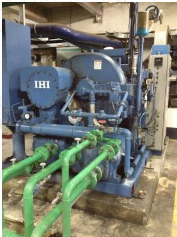
รูปที่ 4.27 เครื่องอัดอากาศ (Air Compressor) เครื่องที่ 18 IHI Tx-A290L (Turbo)
