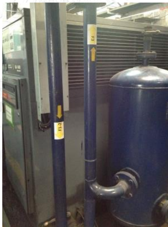
รูปที่ 4.13 เครื่องอัดอากาศ (Air Compressor) เครื่องที่ 4 Atlas cooper GA- 1408W (Rotary Screw)
