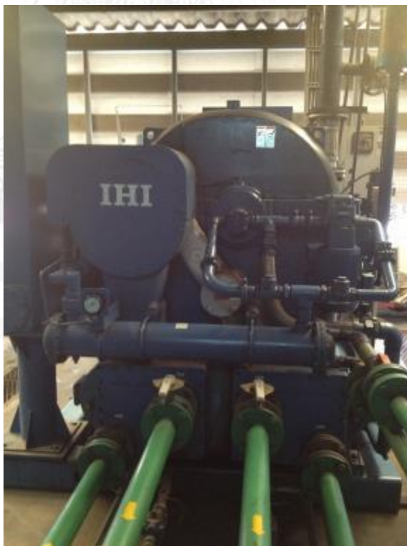
รูปที่ 4.25 เครื่องอัดอากาศ (Air Compressor) เครื่องที่ 16 IHI Tx-A200 (Turbo)
