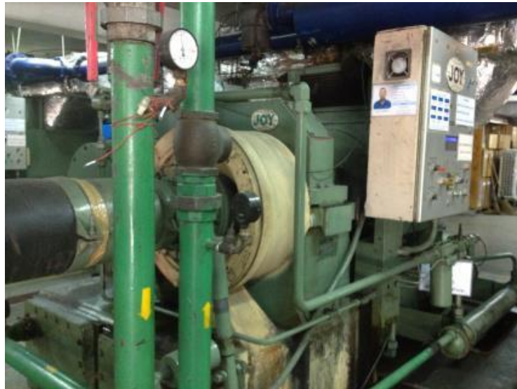
รูปที่ 4.10 เครื่องอัดอากาศ (Air Compressor) เครื่องที่ 1 JOY TA-38 (Turbo)
