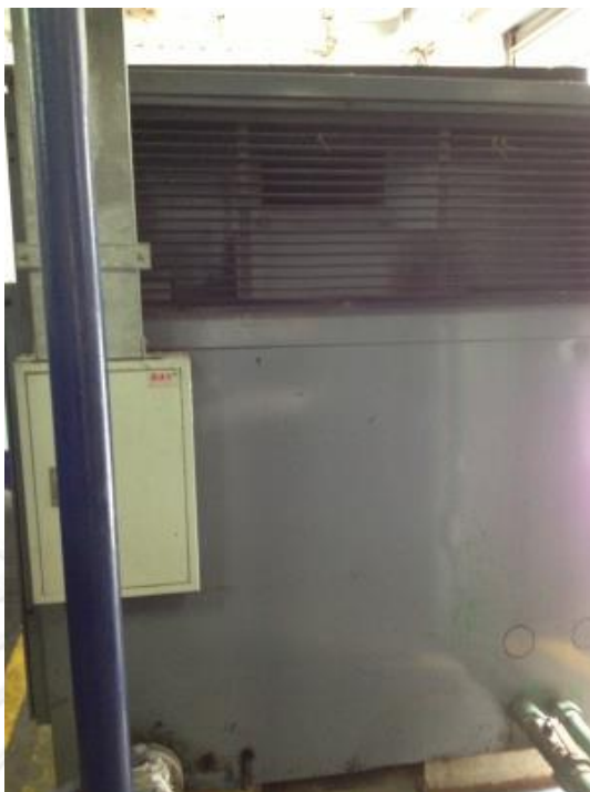
รูปที่ 4.16 เครื่องอัดอากาศ (Air Compressor) เครื่องที่ 7 Atlas cooper GA-1408W (Rotary Screw)
