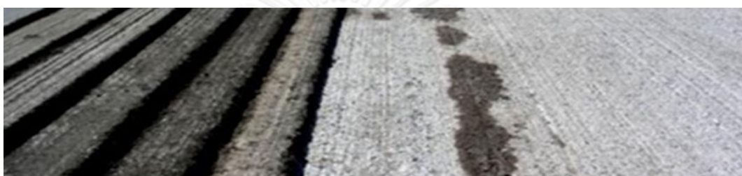
รูปที่ 2.13 การซึมผ่านของน้ำจากชั้นล่างขึ้นสู่ผิวบนจากรอยการหดตัวของโครงสร้างทาง
