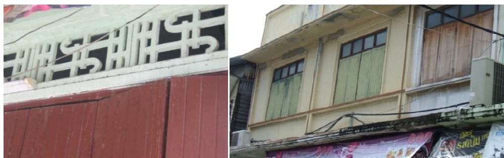
ภาพที่ 4.24 รายละเอียดตกแต่งอาคารเช่น ช่องลมเหนือประตู (ซ้าย) และคิ้วบัวหน้าต่างและชายคา
