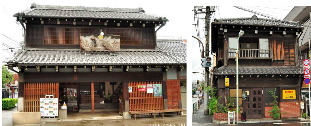
ภาพที่ 2.8 มรดกทางสถาปัตยกรรม ร้านค้าที่สร้างจากไม้เก่าแก่ภายในย่านยานากะ [ที่มา: http://muza-chan.net ]
