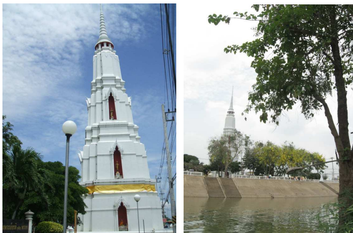
ภาพที่ 3.4 เจดีย์หลวงพ่อแสง (ซ้าย) และมุมมองจากท่าน้ำตลาดล่าง (ขวา)
