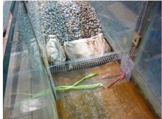
การติดตั้งกรงหิน ชั้นถุทราย และชั้นหินทิ้ง
