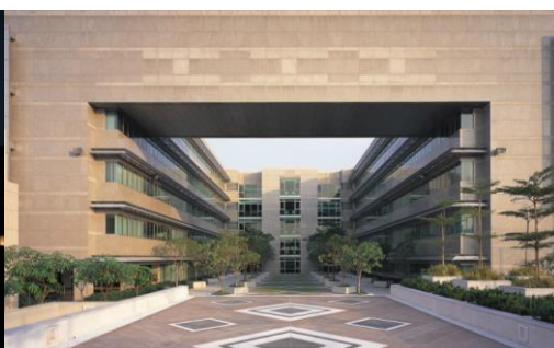
รูปภาพที่ 23 อาคารกระทรวงการต่างประเทศ ที่มา: บริษัท สถาปนิก 49 จำกัด
