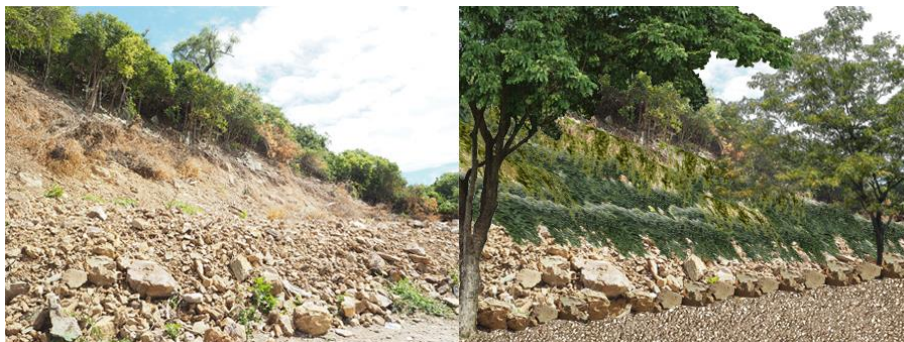
ภาพที่ 72 การปลูกพืชคลุมดินร่วมกับเทคนิคทางวิศวกรรม บริเวณพื้นที่ลาดชัน และการสร้างลานจอดรถที่ใช้วัสดุซีเมนต์ ร่วมกับการปลูกไม้ใหญ่ให้ร่มเงา
