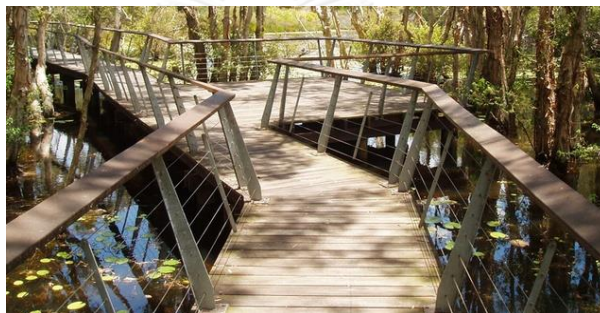
ภาพที่ 68 แสดงตัวอย่างสะพานที่ใช้โครงสร้างเหล็กผสมกับวัสดุไม้เทียม
