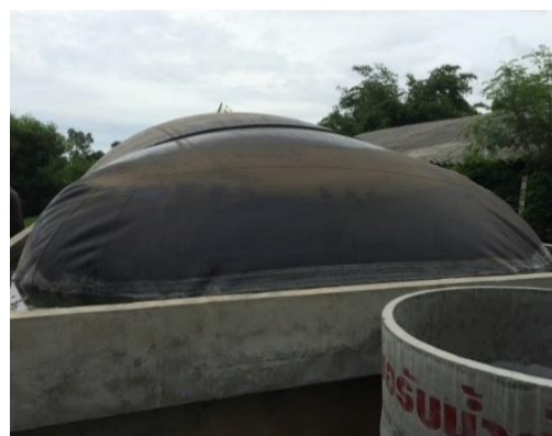
รูปที่ 15 บ่อน้ำล้นที่ใช้สำหรับปล่อยกากตะกอนโรงปุ๋ยอินทรีย์ที่ค้างภายในระบบผลิตก๊าซชีวภาพ
