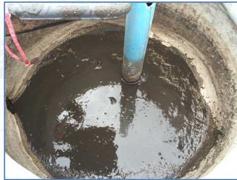
รูปที่ 9 บ่อล้นหมักตะกอนตะกอนจุลินทรีย์ชีวภาพที่เป็นจุดเก็บกากตะกอนโรงปุ๋ยชีวภาพ
