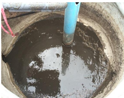
รูปที่ 15 บ่อน้ำล้นที่ใช้สำหรับปล่อยกากตะกอนโรงปุ๋ยอินทรีย์ที่ค้างภายในระบบผลิตก๊าซชีวภาพ
