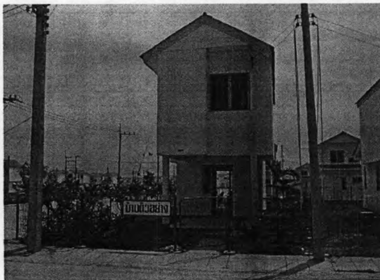
ภาพที่ 5.9 ผลการก่อสร้างโครงการแล้วเสร็จ
