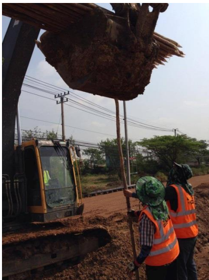
รูปที่ 5.25 รถตักทำการตอกไม้ยูคาลิปตัส เพื่อทำเป็นหลักยึด
