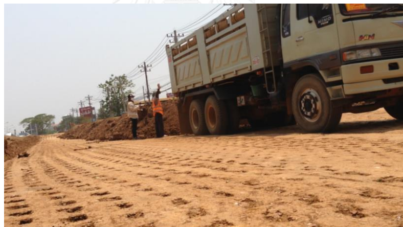
รูปที่ 5.3 คนงาน (ดั้มพ์แมน) ส่งสัญญาณให้รถบรรทุกทำการเทดิน
