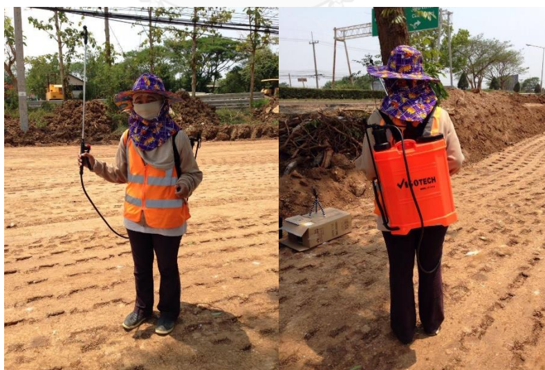
รูปที่ 5.7 การติดตั้งเครื่องมือฉีดพ่นน้ำชนิดมือโยกกับคนงาน
