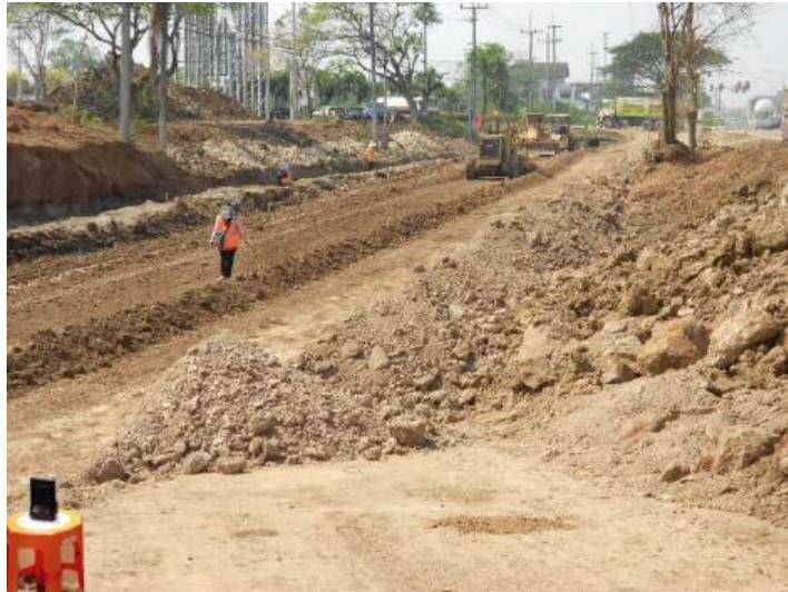
รูปที่ 4.23 ตำแหน่งจุดวัดที่ 4 : บริเวณพื้นที่ก่อสร้างได้ลม
