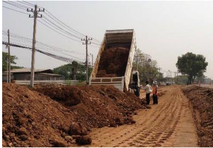
รูปที่ 4.15 ตำแหน่งจุดวัดที่ 1: บริเวณจุดที่เกิดก่อสร้าง
