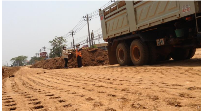
รูปที่ 5.2 รถบรรทุกเคลื่อนที่เข้าสู่บริเวณก่อสร้างตามที่คนงาน (ดั้มพ์แมน) ได้กำหนดไว้
