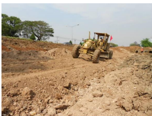
รูปที่ 5.19 รถเกลี่ยดิน (Grader) ทำการล้มนกองดินเพื่อปรับเกลี่ยดิน
