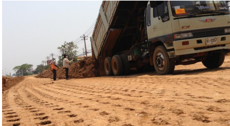
รูปที่ 5.4 รถบรรทุกทำการเทดินลงในพื้นที่ที่เตรียมไว้
