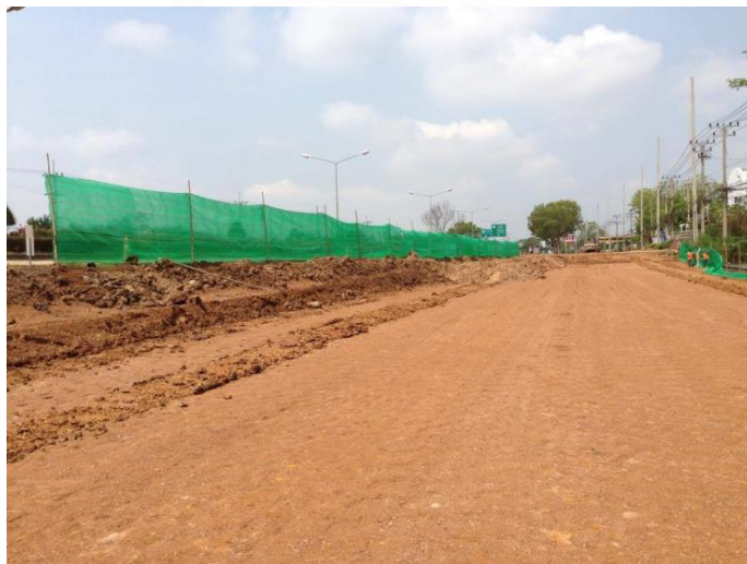
รูปที่ 5.28 ภาพรวมหลังจากที่ทำการผูกเชือกฟางกับแผงกั้นฝุ่นละออง
