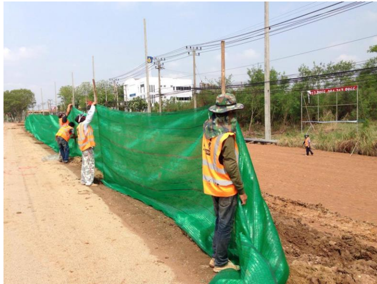
รูปที่ 5.27 ผูกเชือกฟางกับแผงกั้นฝุ่นละอองติดกับไม้ยูคาลิปตัส
