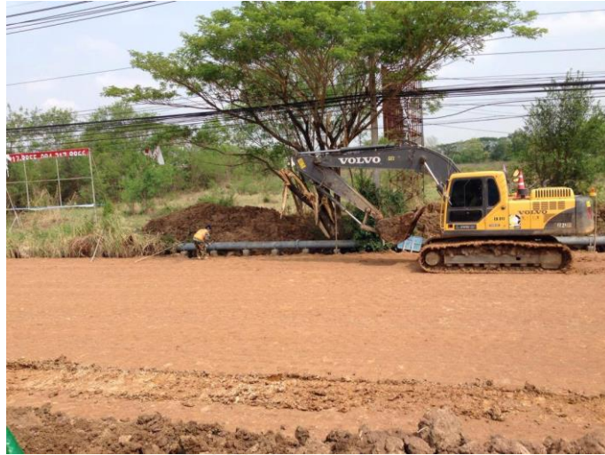
รูปที่ 5.29 เริ่มทำการติดตั้งแผงกั้นฝุ่นละอองอีกด้านของบริเวณก่อสร้าง
