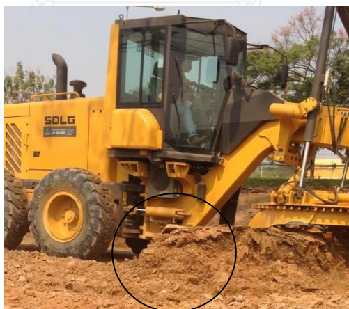
รูปที่ 5.21 การเกลี่ยดินของรถเกลี่ยดินเป็นกิจกรรมที่ทำให้เกิดฝุ่นละออง
