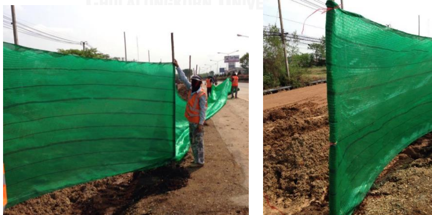
รูปที่ 5.26 ผูกแผงกันฝุ่นละอองติดกับไม้ยูคาลิปตัส
