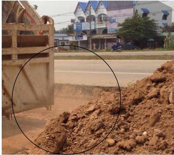
รูปที่ 4.2 แหล่งกำเนิดของฝุ่นละอองจากกิจกรรมเทดิน (ตัมพ์ดิน)
