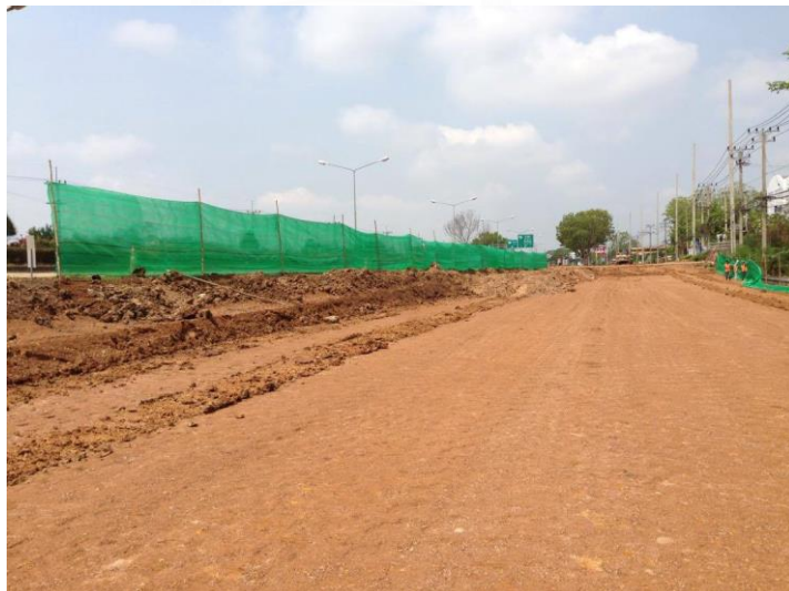
รูปที่ 5.30 การติดตั้งแผงกั้นฝุ่นละอองอีกด้านหนึ่งในบริเวณก่อสร้าง
