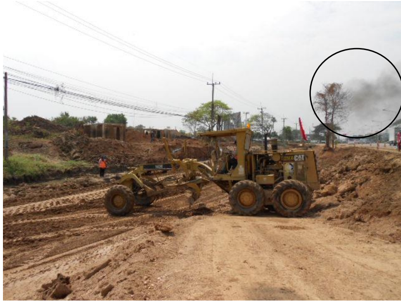
รูปที่ 4.4 แหล่งกำเนิดของฝุ่นละอองจากควันจากท่อไอเสียของรถเกลี่ยดิน (Grader)
