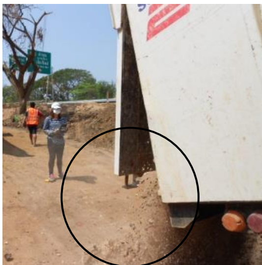
รูปที่ 5.6 แหล่งกำเนิดฝุ่นละอองในขั้นตอนการเทดินในกิจกรรมเทดิน
