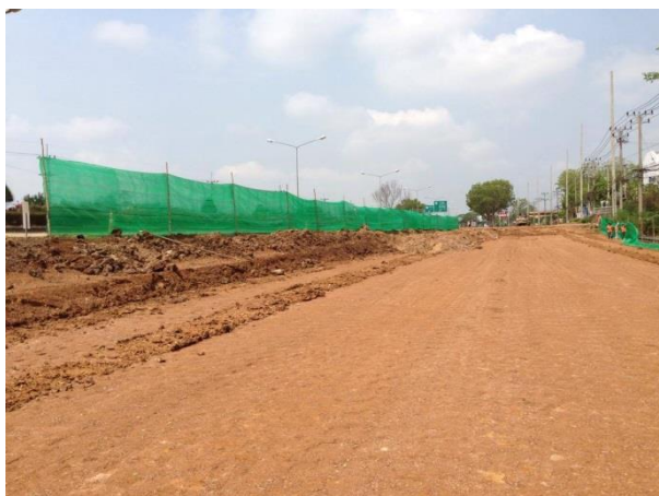
รูปที่ 5.22 การติดตั้งแผงกันฝุ่น ครอบคลุมบริเวณโครงการก่อสร้าง
