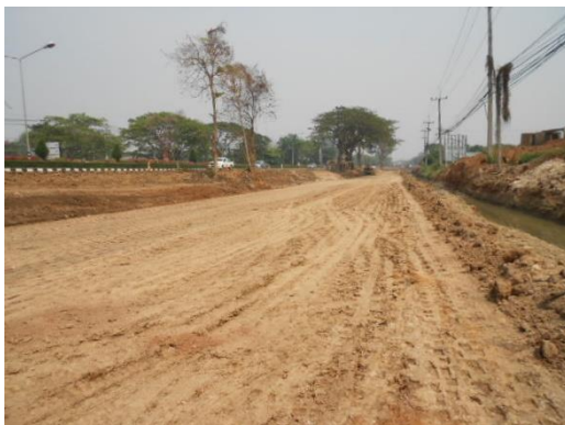
รูปที่ 5.20 ลักษณะของชั้นดินที่ได้ความแน่นตามรูปแบบ
