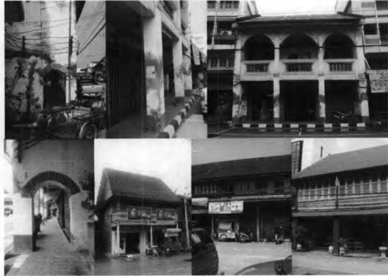
รูปที่ 5.1 สภาพทางเดินเท้าหน้าอาคารพาณิชย์เก่าบนถนนเจริญเมือง
